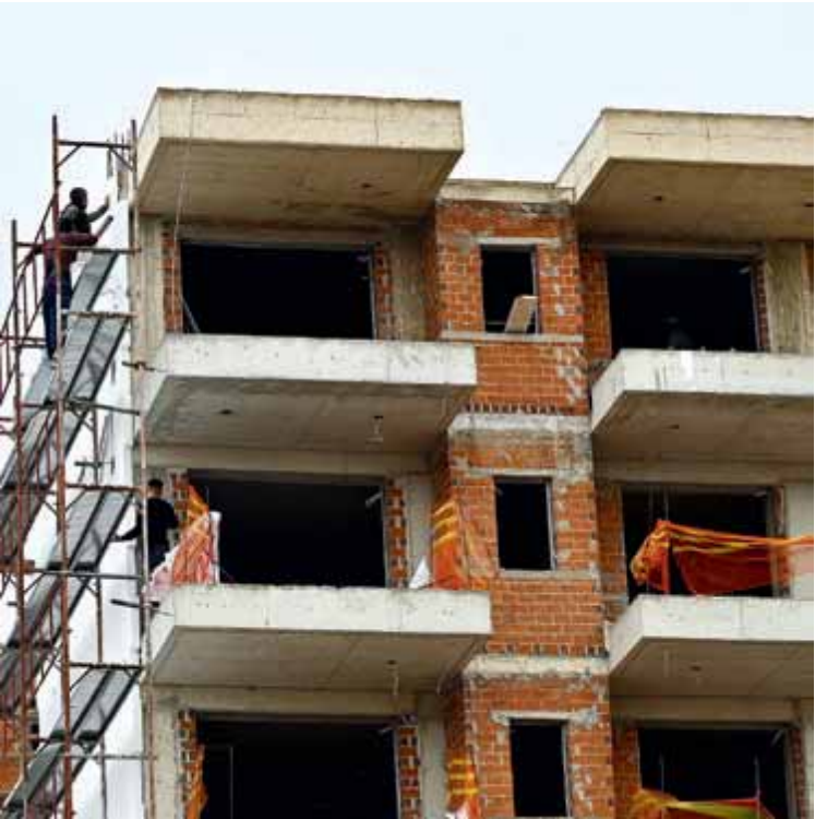
Το 2025 στην Ελλάδα εκκίνησε η κατασκευή μόλις 30.000 νέων κατοικιών.
