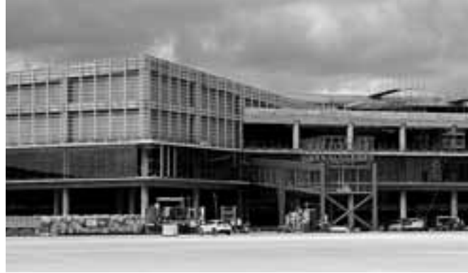
Το έργο στο Καστέλλι βρίσκεται πλέον στο τελικό του στάδιο, με τις εργασίες να επικεντρώνονται στην προετοιμασία του αεροδρομίου για λειτουργία και στην ολοκλήρωση των ρυθμιστικών απαιτήσεων που απαιτούνται πριν από την έναρξη των εμπορικών πτήσεων.
