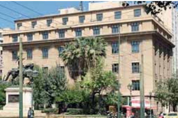
Στην πλατεία Παλαιάς Βουλής «δεσπόζει» το παλιό κτίριο του ΟΤΕ. Τέσσερα χρόνια μετά την εξασφάλιση επιδότησης, το έργο ανάπλασης δεν έχει ακόμα εκκινήσει.
