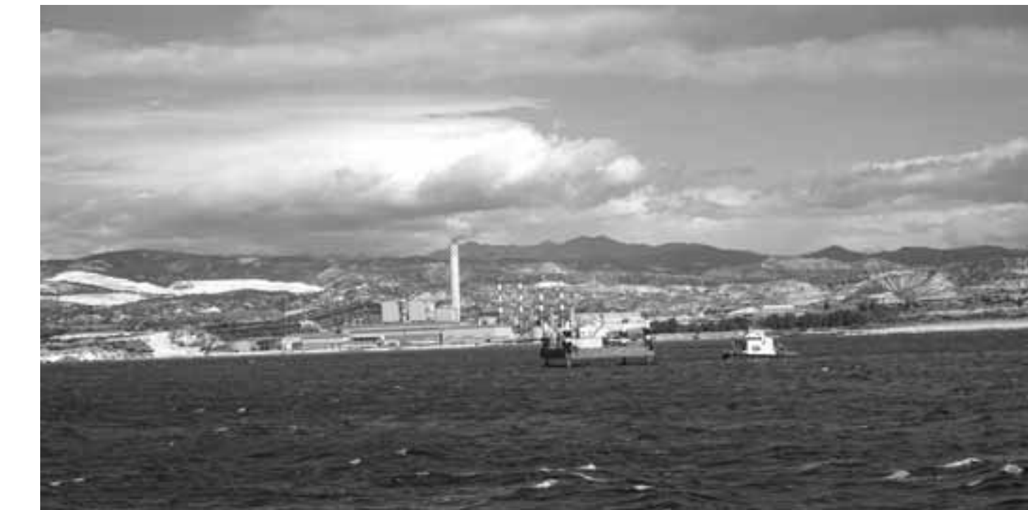
Εν μέσω σοβαρών αποφάσεων που πρέπει να ληφθούν το επόμενο διάστημα για το τερματικό στο Βασιλικό, πληθαίνουν οι απόψεις εκείνες που βλέπουν ότι το ενεργειακό έργο κινδυνεύει να ολοκληρωθεί το 2029.
