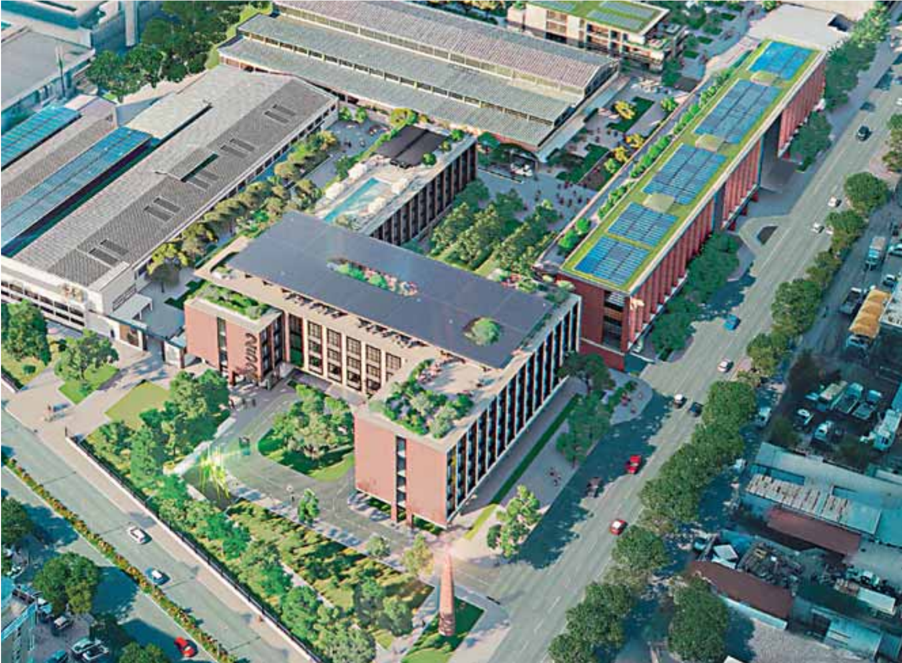
Στην οδό Πειραιώς 252 η Noval προχωράει την ανάληψη του ακινήτου της παλιάς Χαλκόρ, που ήταν και η πρώτη παραγωγική μονάδα του ομίλου Viohalco. Η επένδυση θα ξεπεράσει τα 200 εκατ. ευρώ και προβλέπει την ανάπτυξη δομήσιμης επιφάνειας άνω των 50.000 τ.μ., στην οποία θα αναπτυχθούν κατοικίες, ξενοδοχείο, γραφεία και καταστήματα, παράλληλα με χώρους πολιτισμού κι ένα σημαντικής έκτασης πάρκο.
