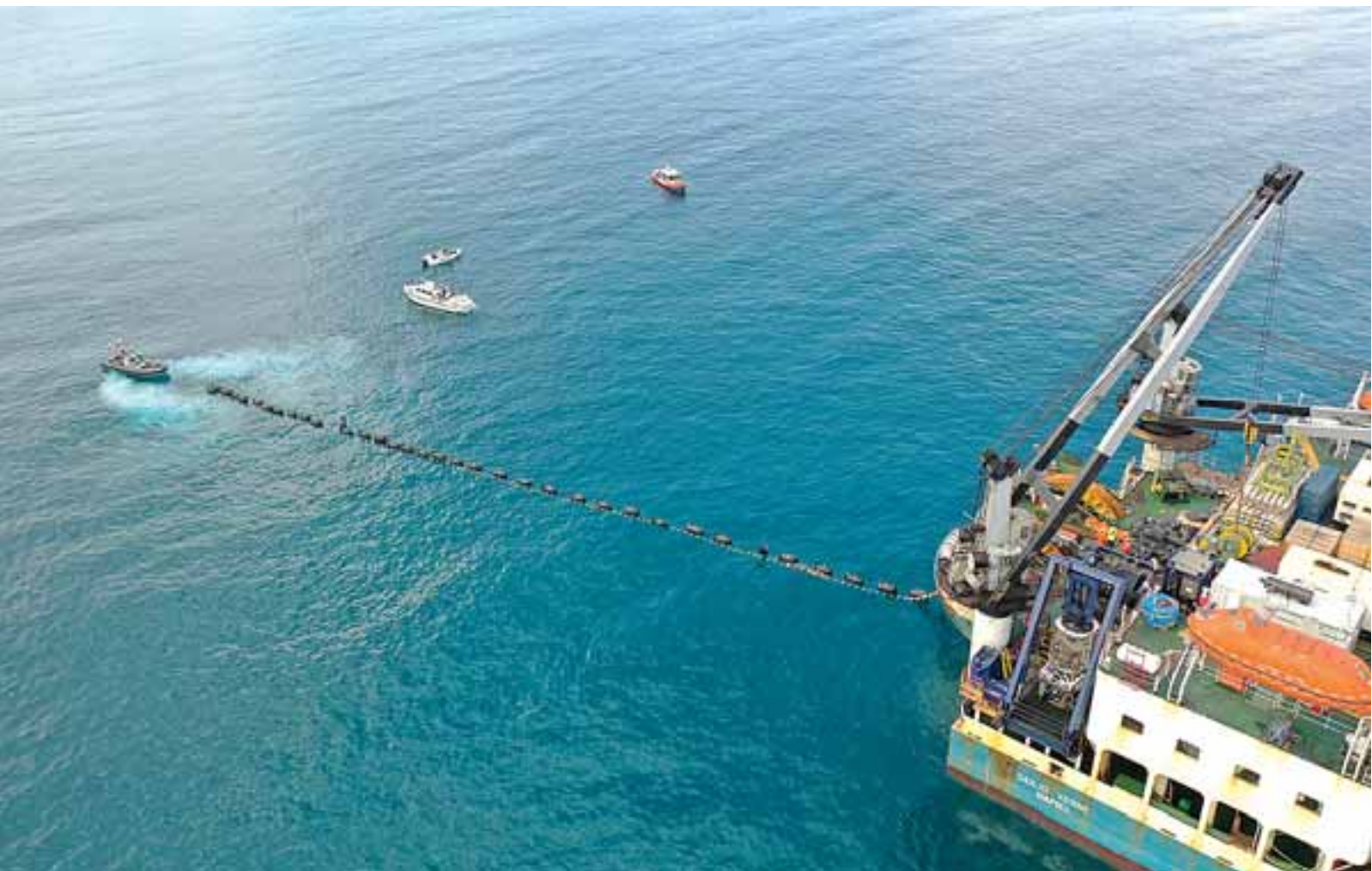
Κατά τις επαφές του Προέδρου της Δημοκρατίας στο Ισραήλ η ισραηλινή πλευρά απέφυγε να αναφερθεί στον GSI, δίνοντας προτεραιότητα στη διασύνδεση Κύπρου - Ισραήλ μέσω του Διαδρόμου Οικονομικής Συνεργασίας Ινδίας - Μέσης Ανατολής - Ευρώπης (India - Middle East - Europe Economic Corridor, IMEC).
