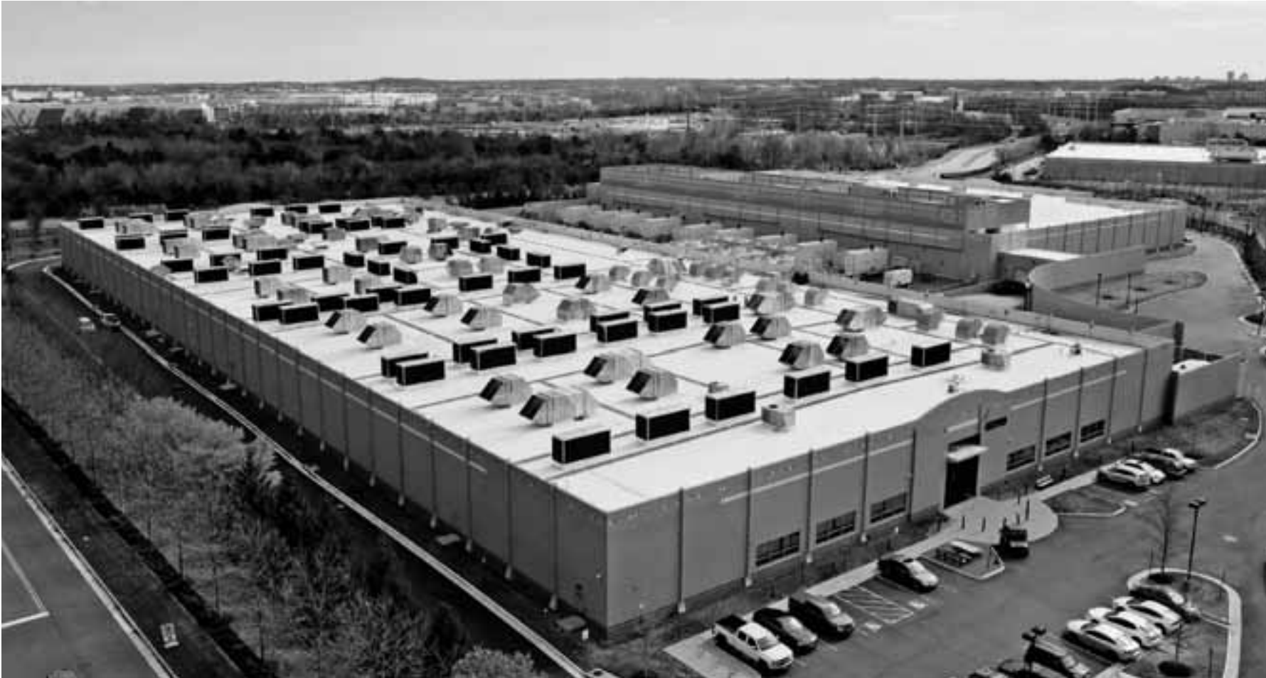
Η Data Center Alley , μια έκταση 78 τετραγωνικών χιλιομέτρων έξω από την Ουάσιγκτον, όπου έχουν κατασκευαστεί περισσότερα από 200 data centers, καταναλώνει περίπου την ίδια ηλεκτρική ενέργεια με ολόκληρη τη Βοστώνη.
