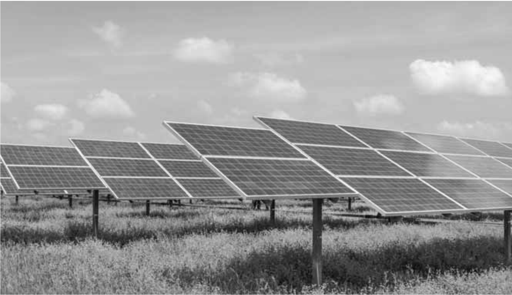
Ανοίγει ο δρόμος για κατασκευή κεντρικών αποθηκευτικών συστημάτων αποθήκευσης ηλεκτρισμού - Μείωση ενός σεντ ανά κιλοβατώρα το όφελος για τους καταναλωτές.
