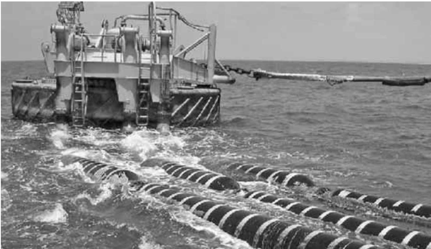
Μέχρι τον Μάρτιο θα έχουν ξεκινήσει οι εργασίες βυθομέτρησης, σε διεθνή ύδατα, για την πόντιση του ηλεκτρικού καλωδίου, υποστηρίζουν πηγές στην ελληνική πρωτεύουσα. Για την ώρα τα δυο ερευνητικά πλοία παραμένουν αγκυροβολημένα στην Κρήτη.
