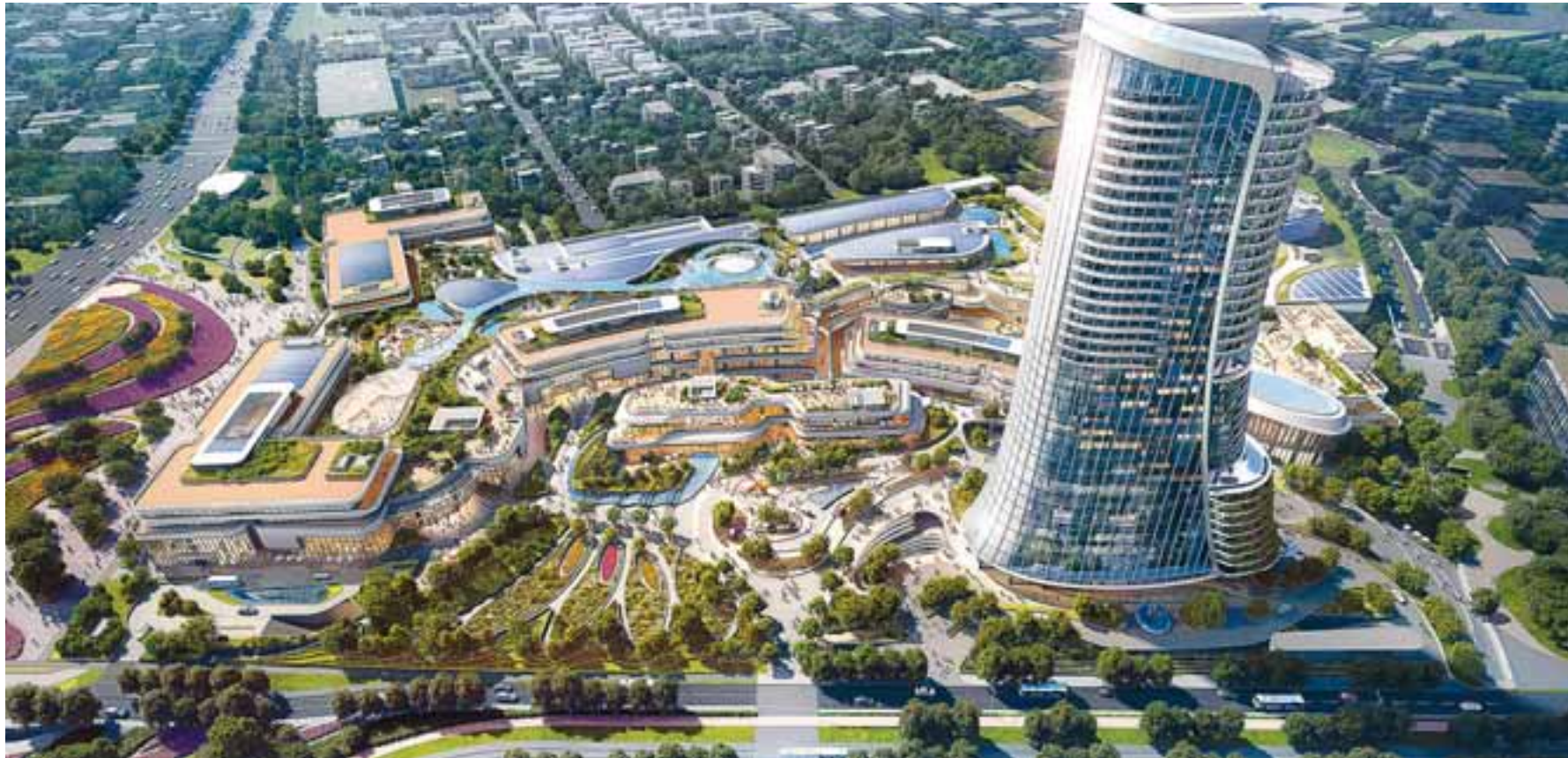
Το εμπορικό κέντρο Ellinikon Mall, που όταν λειτουργήσει θα είναι και το μεγαλύτερο της χώρας, με διαφορά από το δεύτερο (The Mall Athens). Ένα έργο που θα απαιτήσει τουλάχιστον 600 εκατ. ευρώ και η κατασκευή του προβλέπεται να ξεκινήσει εντός του πρώτου εξαμήνου. Θα είναι επιφάνειας 100.000 τ.μ. και θα φιλοξενεί πάνω από 350 καταστήματα και εστιατόρια.
