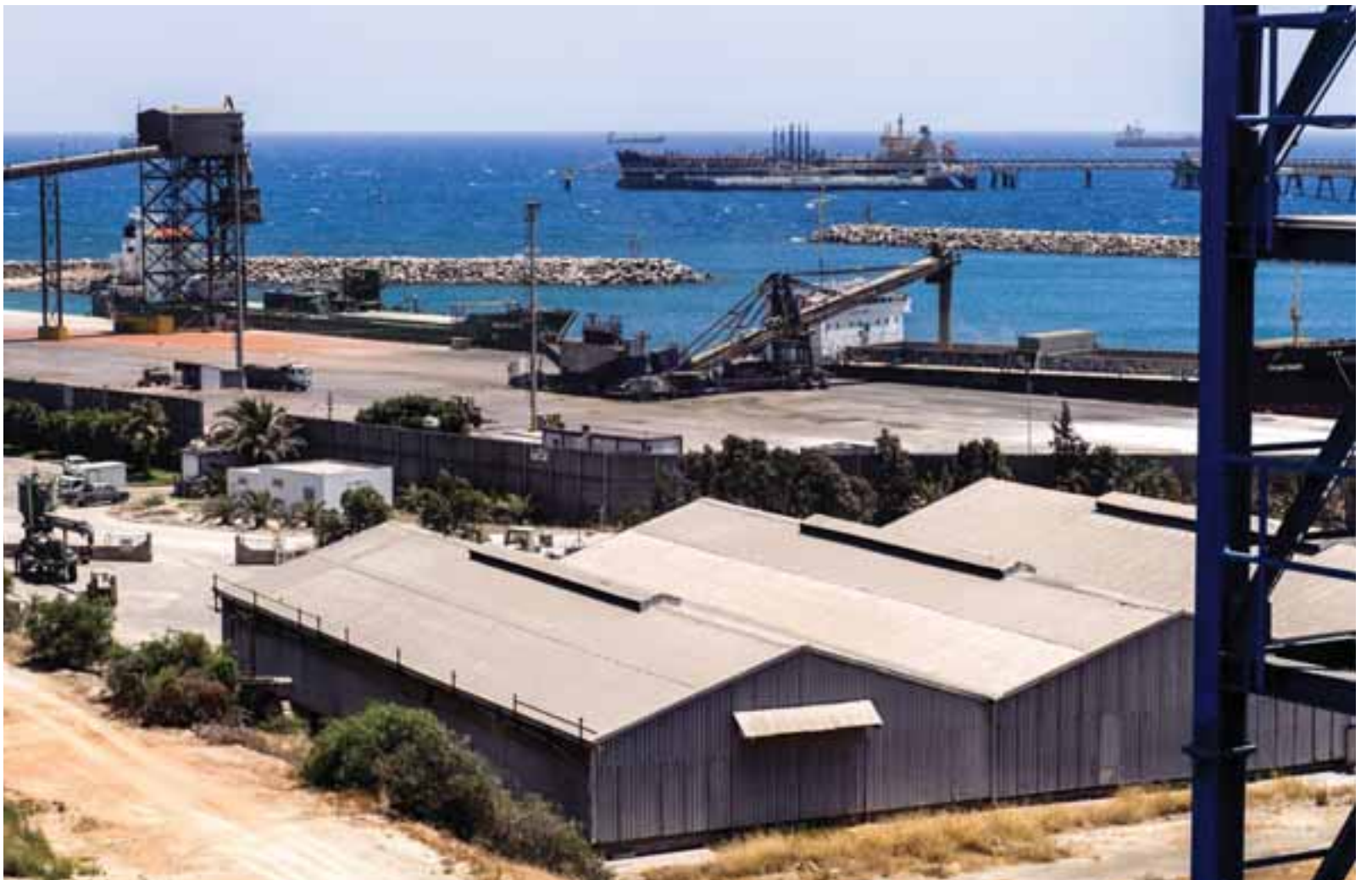
Με πιο στενή εμπλοκή του υπουργείου Ενέργειας στο θέμα παρακολούθησης και διαχείρισης των έργων στο Βασιλικό ξεπεράστηκαν τα εμπόδια που είχαν δημιουργηθεί και που οδήγησαν στη δίμηνη αναστολή των εργασιών.
