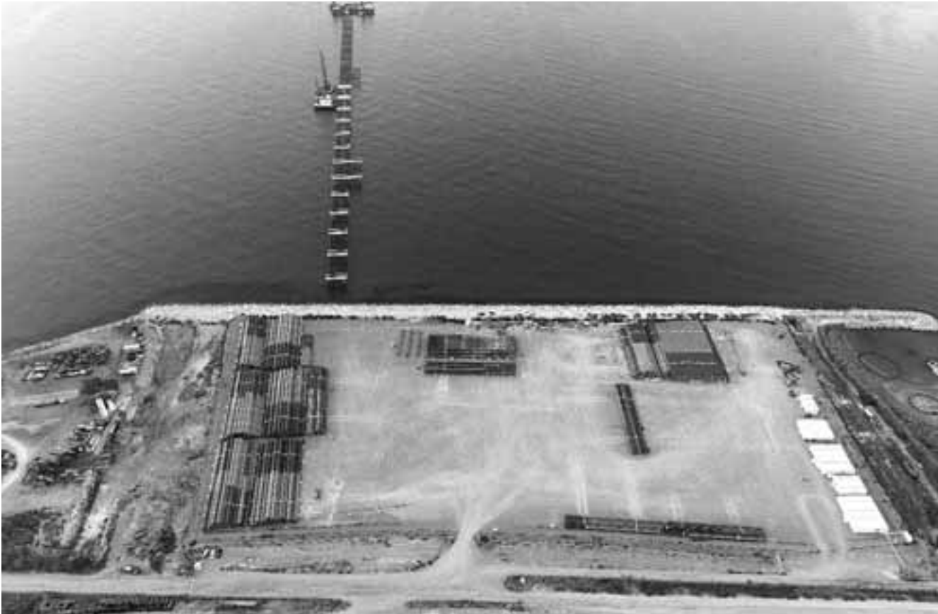
Σε εξέλιξη οι εργασίες για τις θαλάσσιες εγκαταστάσεις του τερματικού στο Βασιλικό. Μέχρι στιγμής έχουν τοποθετηθεί 259 πάσσαλοι που θα στηρίξουν την αποβάθρα. Συνολικά θα τοποθετηθούν 740.
