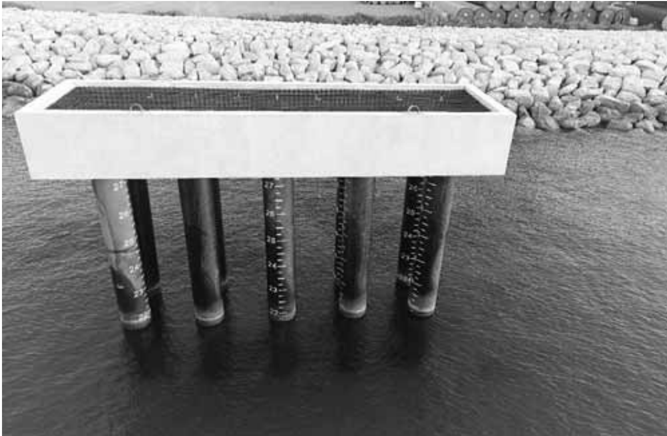
Σε εξέλιξη οι εργασίες για τις θαλάσσιες εγκαταστάσεις του τερματικού στο Βασιλικό. Μέχρι στιγμής έχουν τοποθετηθεί 259 πάσσαλοι που θα στηρίξουν την αποβάθρα. Συνολικά θα τοποθετηθούν 740.
