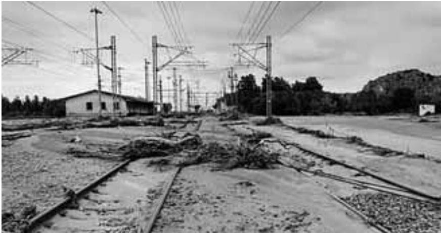
Η κακοκαιρία «έπνιξε» και τα ολοκληρωμένα έργα της περιβόητης σύμβασης 717. Τα έργα σηματοδότησης και τηλεδιοίκησης στο τμήμα Δομοκός - Λάρισα, Λάρισα - Πλατύ, μαζί με την τηλεδιοίκηση από Δομοκό - Πλατύ παρελήφθησαν τέλη Ιουλίου - αρχές Αυγούστου.
