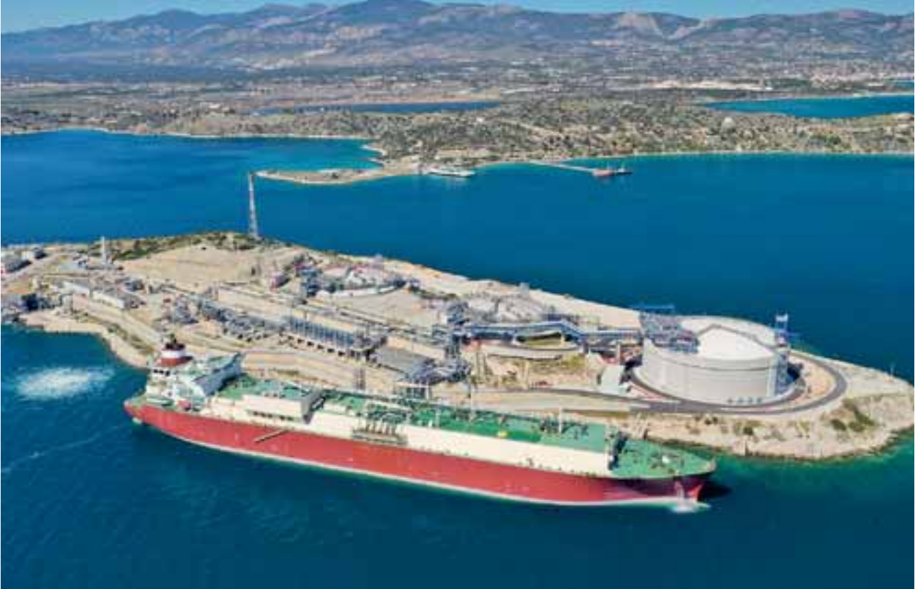
Με τη μόνιμη αγκυροβόληση στον προβλήτα της Ρεβυθούσας ενός ειδικά διαμορφωμένου δεξαμενόπλοιου, η χωρητικότητα των 225.000 κ.μ. αερίου των υφιστάμενων τριών δεξαμενών του νησιού θα αυξηθεί κατά 100.000 κ.μ.
