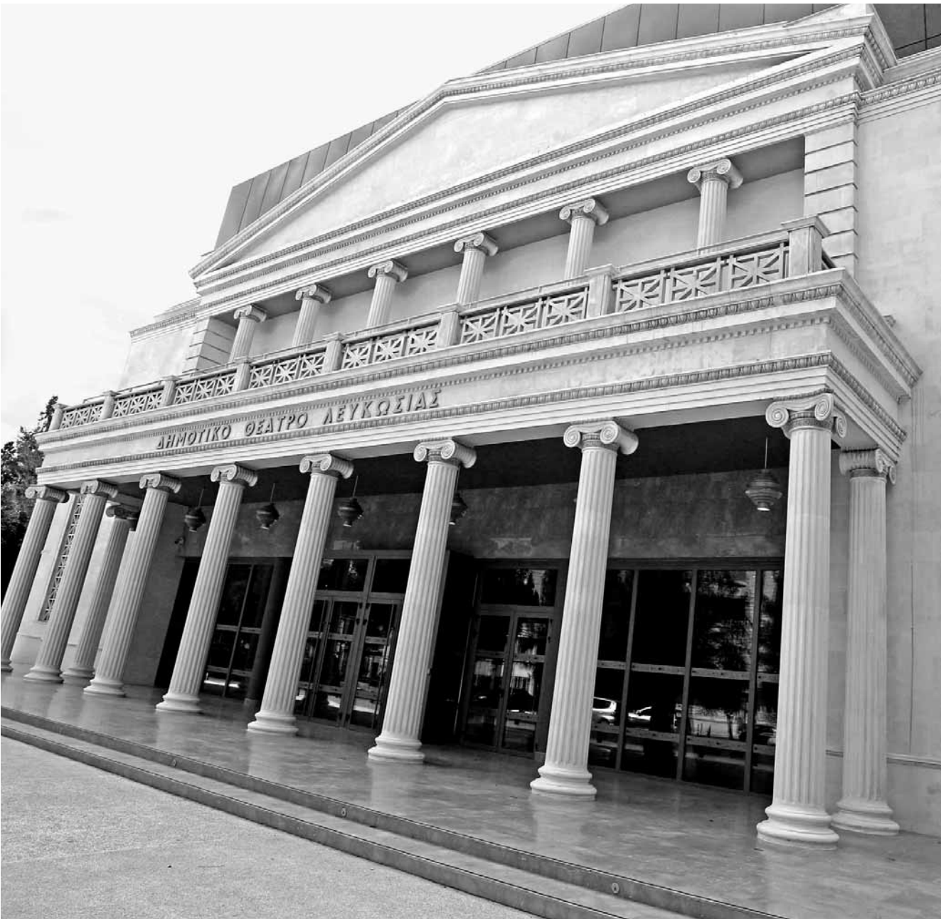
Μεταξύ των έργων τα οποία έχουν ολοκληρωθεί με τη μέθοδο μελέτης κατασκευής είναι η αποκατάσταση του Δημοτικού Θεάτρου Λευκωσίας, η αίθουσα εκδηλώσεων του Προεδρικού και το Συνεδριακό Κέντρο «Φιλοξενία».
