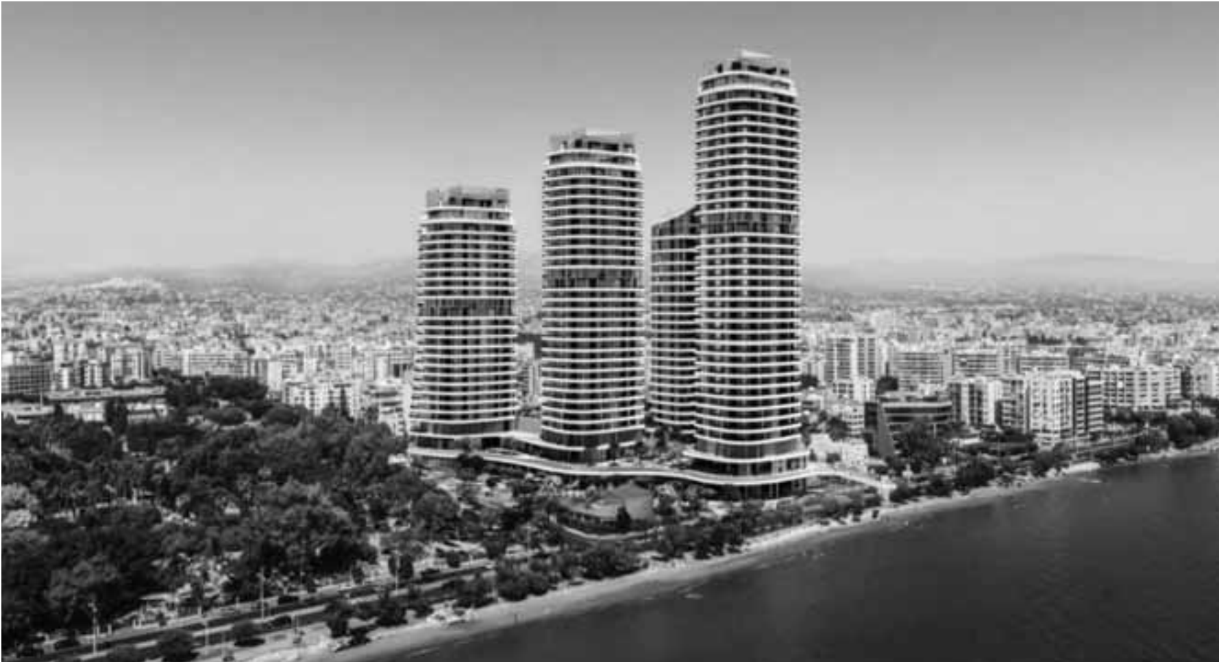
Όλα τα κτήρια που κατασκευάστηκαν μετά το 1994 θεωρούνται αντισεισμικά. Υπάρχει ωστόσο ζήτημα για τα παλαιότερα κτήρια που κτίστηκαν εκτός του αντισεισμικού πλαισίου, στα ο-ποία εμπίπτουν και κτήρια που στεγάζουν τμήματα δημόσιας υπηρεσίας και υπουργεία.
