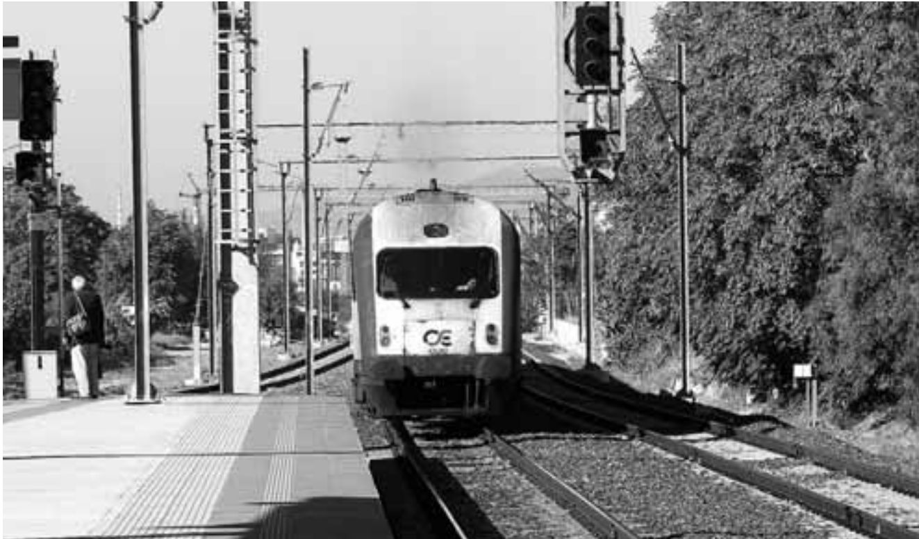
Ανάμεσα στα έργα που σχεδιάζονται είναι και η κατασκευή νέας προαστιακής γραμμής, μήκους 31,7 χιλιομέτρων, στο τμήμα από τον κόμβο Κορωπίου έως το Λαύριο και το λιμάνι της πόλης.
