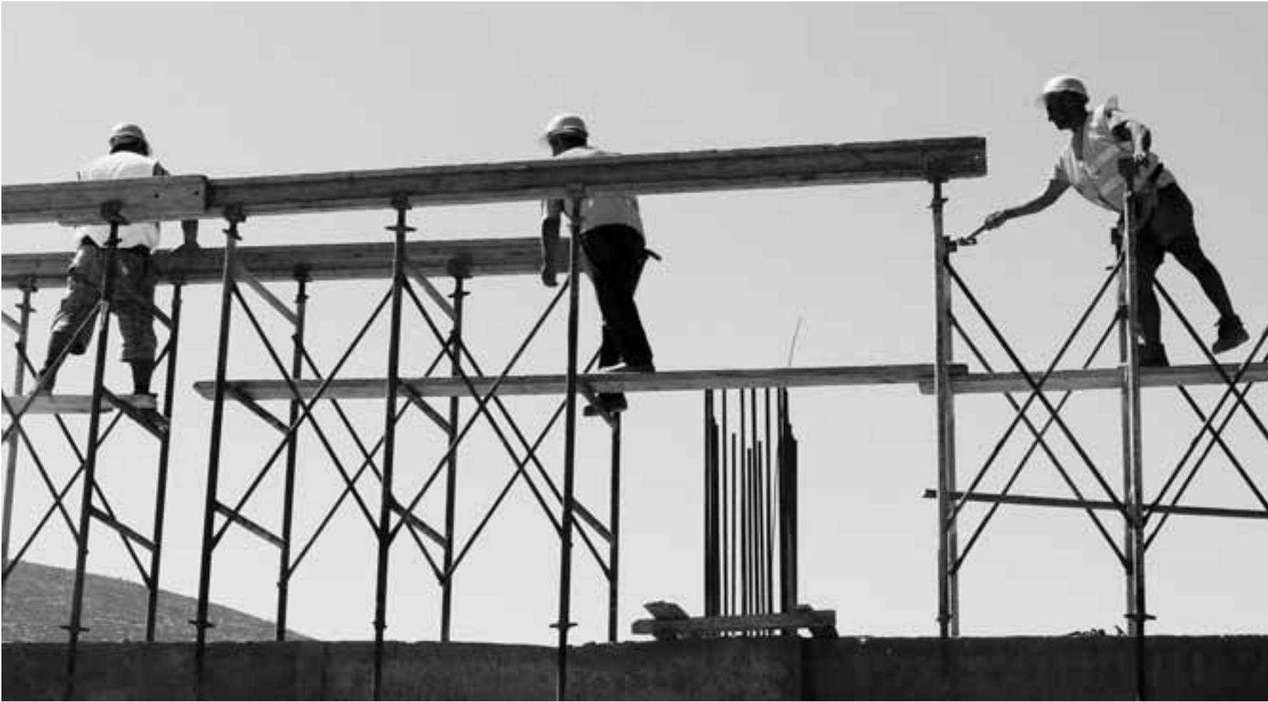
Η αύξηση στο κόστος κατασκευής οικοδομής προκαλείται και από τη συνεχή ανατίμηση του πετρελαίου, αλλά και από το ράλι στις τιμές των μετάλλων. Το μέσο κόστος ανέγερσης ανά τετραγωνικό μέτρο ανέρχεται πλέον ακόμη και στα 1.300 ευρώ.
