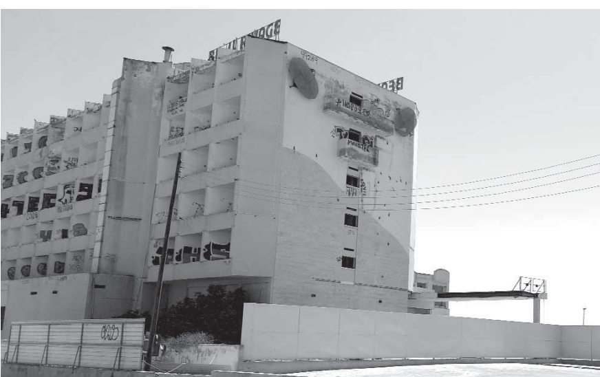
Πρώτη εβδομάδα Οκτωβρίου αναμένεται να ξεκινήσουν οι διαδικασίες κατεδάφισης του εγκαταλειμμένου ξενοδοχείου Beau Rivage. Τη θέση του θα πάρει μικρή τουριστική ανάπτυξη με κόστος 50 εκατ. ευρώ.
