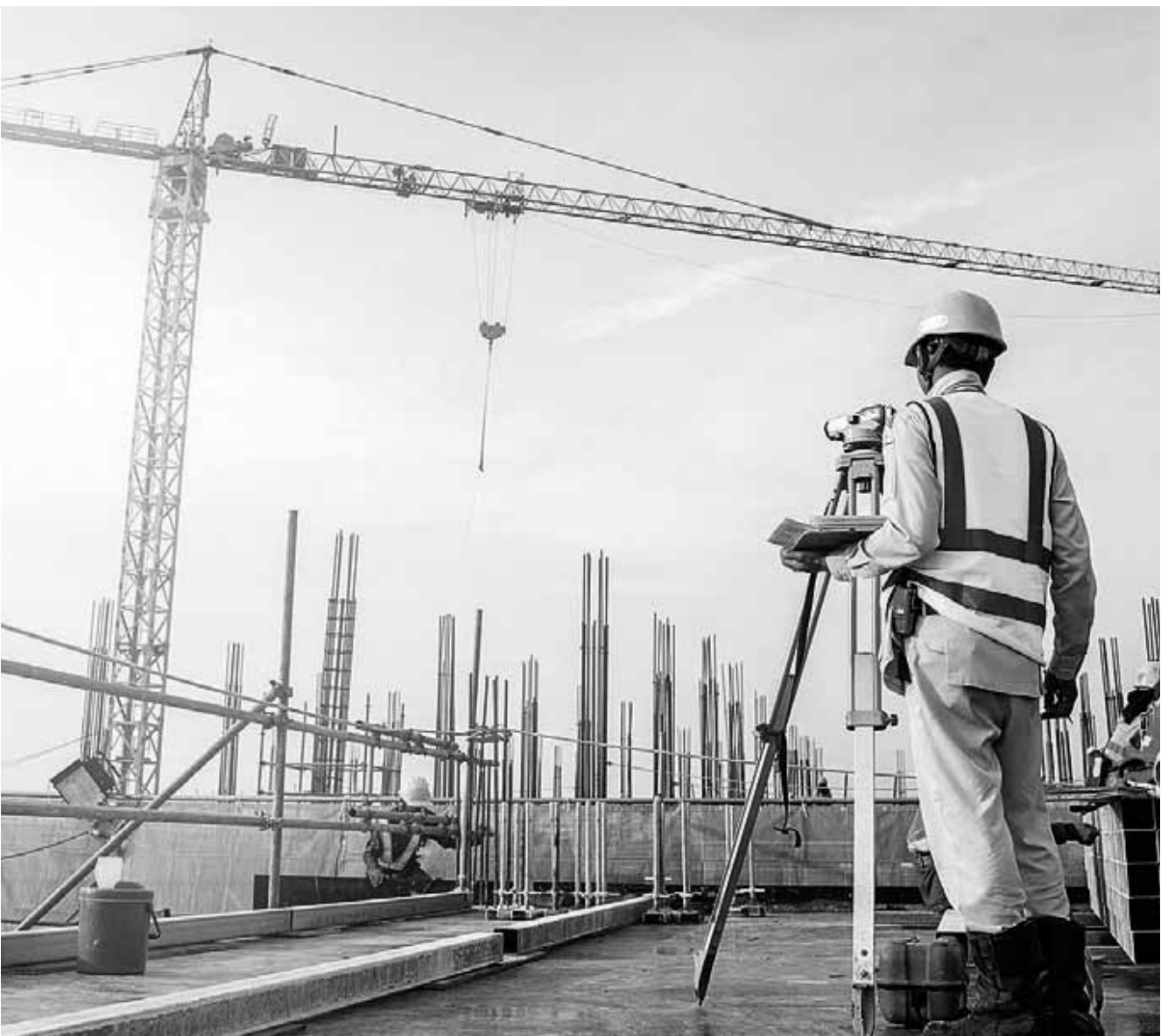
Επιπλέον επιβάρυνση στα κατασκευαστικά έργα προκαλεί και η αύξηση των τιμών του πετρελαίου, που είναι καθοριστικός παράγοντας όχι μόνο στο κόστος χρήσης των μηχανημάτων αλλά και σε υλικά, όπως τα ασφαλτικά προϊόντα και οι πλαστικοί σωλήνες. Μεγάλες αυξήσεις, τουλάχιστον κατά 50%, έχει καταγράψει και ο σίδηρος.
