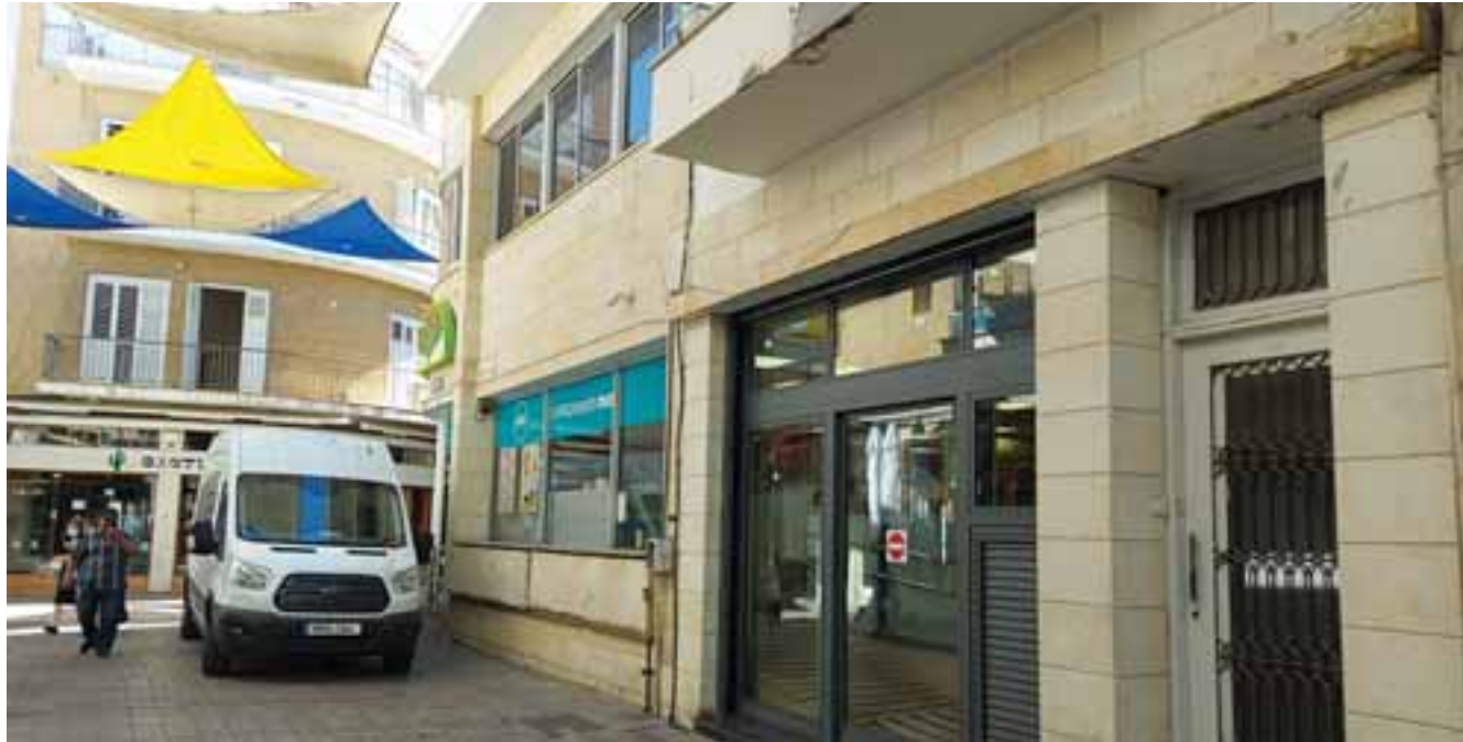
Σε αναβαθμίσεις ύψους 65,6 χιλιάδων ευρώ προχωρά η διεύθυνση της μικρής υπεραγοράς GreenTree στην Ονασαγόρου. Οι εργασίες θα ξεκινήσουν τις επόμενες εβδομάδες και αναμένεται ότι θα ολοκληρωθούν αρχές του 2022.
