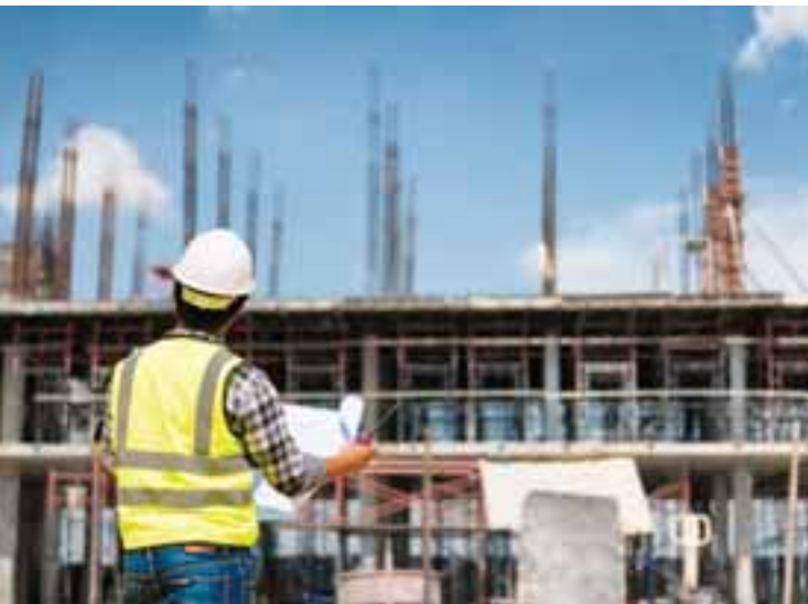
Διερευνώνται καταγγελίες για ξένους εργαζομένους που εργάζονται σε υποβαθμισμένες και επικίνδυνες συνθήκες και κοιμούνται στα εργοτάξια.
