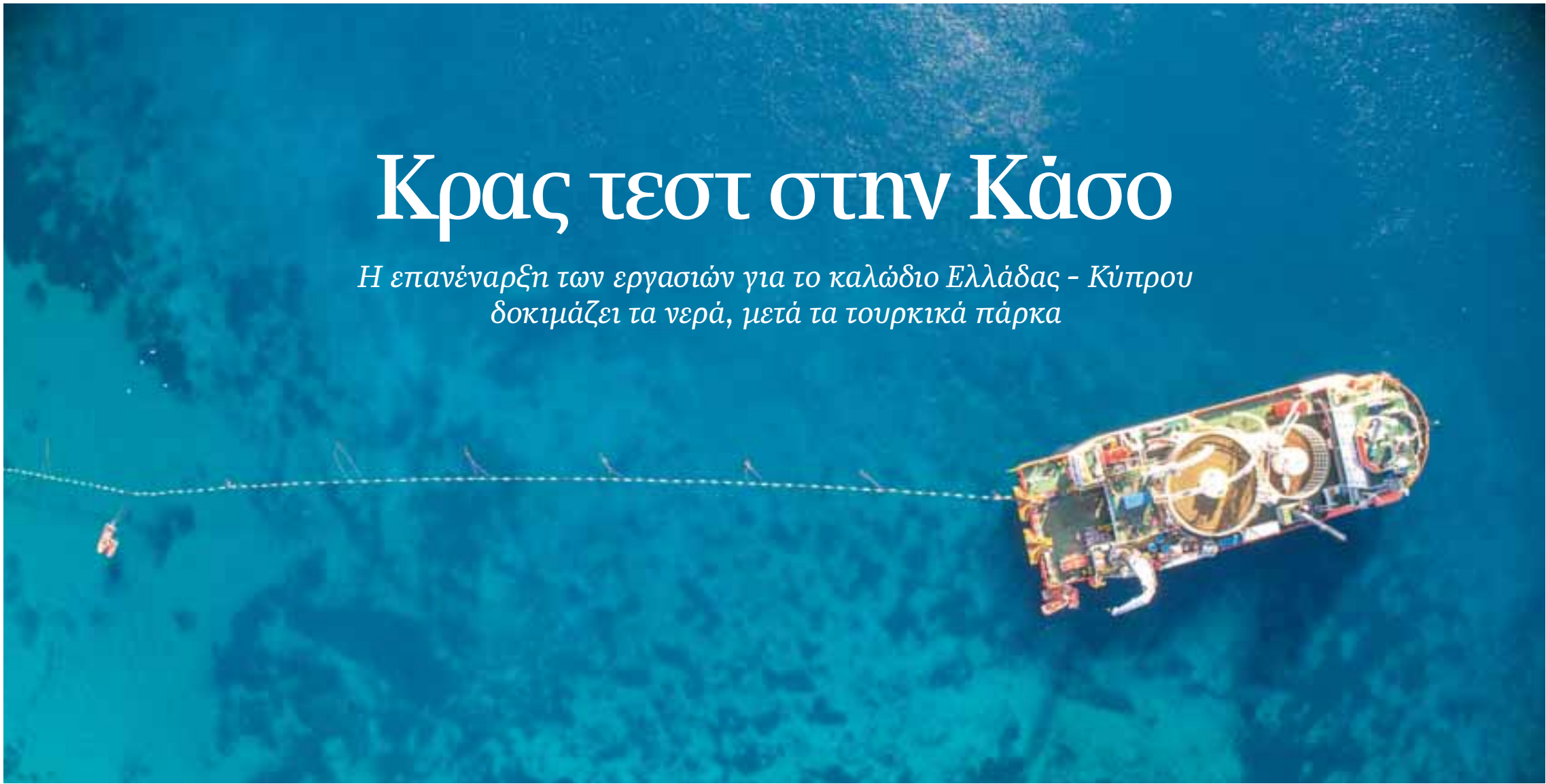
Εργασίες διασύνδεσης της ηπειρωτικής Ελλάδας με τα νησιά από τον ΑΔΜΗΕ. Η επανέναρξη των εργασιών για το καλώδιο ηλεκτρικής διασύνδεσης Ελλάδας - Κύπρου έφερε και το μήνυμα από την τουρκική πλευρά ότι θα πρέπει να ενημερωθεί και επί της ουσίας να δώσει τη συγκατάθεσή της. Το ερώτημα είναι αν η Αγκυρα θα περιοριστεί σε καταγγελίες ή θα επιλέξει να μεταφέρει την ένταση στο πεδίο.
