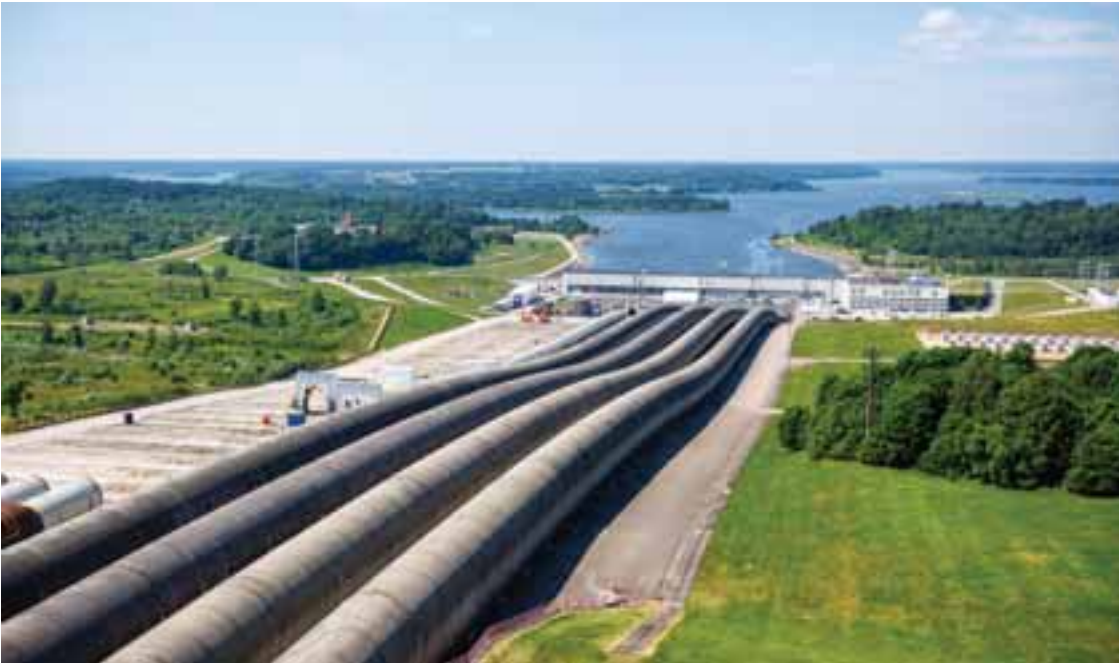
Ο υδροηλεκτρικός σταθμός Kruonis στην περιοχή Kaunas στη Λιθουανία που λειτουργεί ως σύστημα αποθήκευσης ενέργειας.
