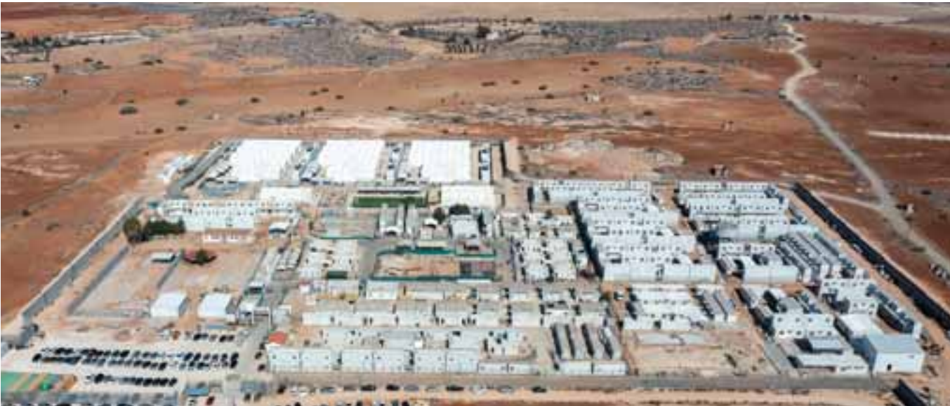
Η υλοποίηση των έργων κρίνεται επιτακτική και αναγκαία, ενώ χωρίς την υποστήριξη και τη χρηματοδότηση της Ευρωπαϊκής Ένωσης, η πραγματοποίησή τους ενδέχεται να μην ήταν δυνατή.
