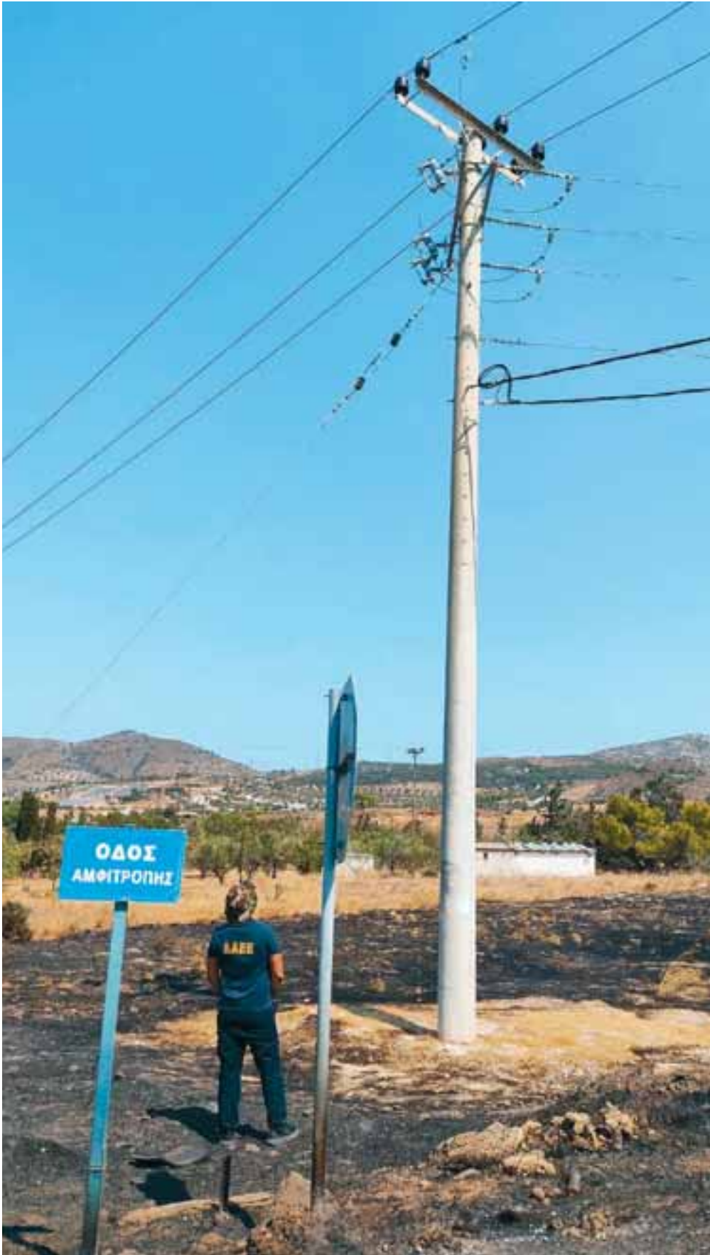
Στέλεχος της Διεύθυνσης Αντιμετώπισης Εγκλημάτων Εμπρησμού μπροστά στον στύλο της οδού Αμφιτρόπης, που ερευνάται για την πρόκληση της πυρκαγιάς στην Κερατέα.
