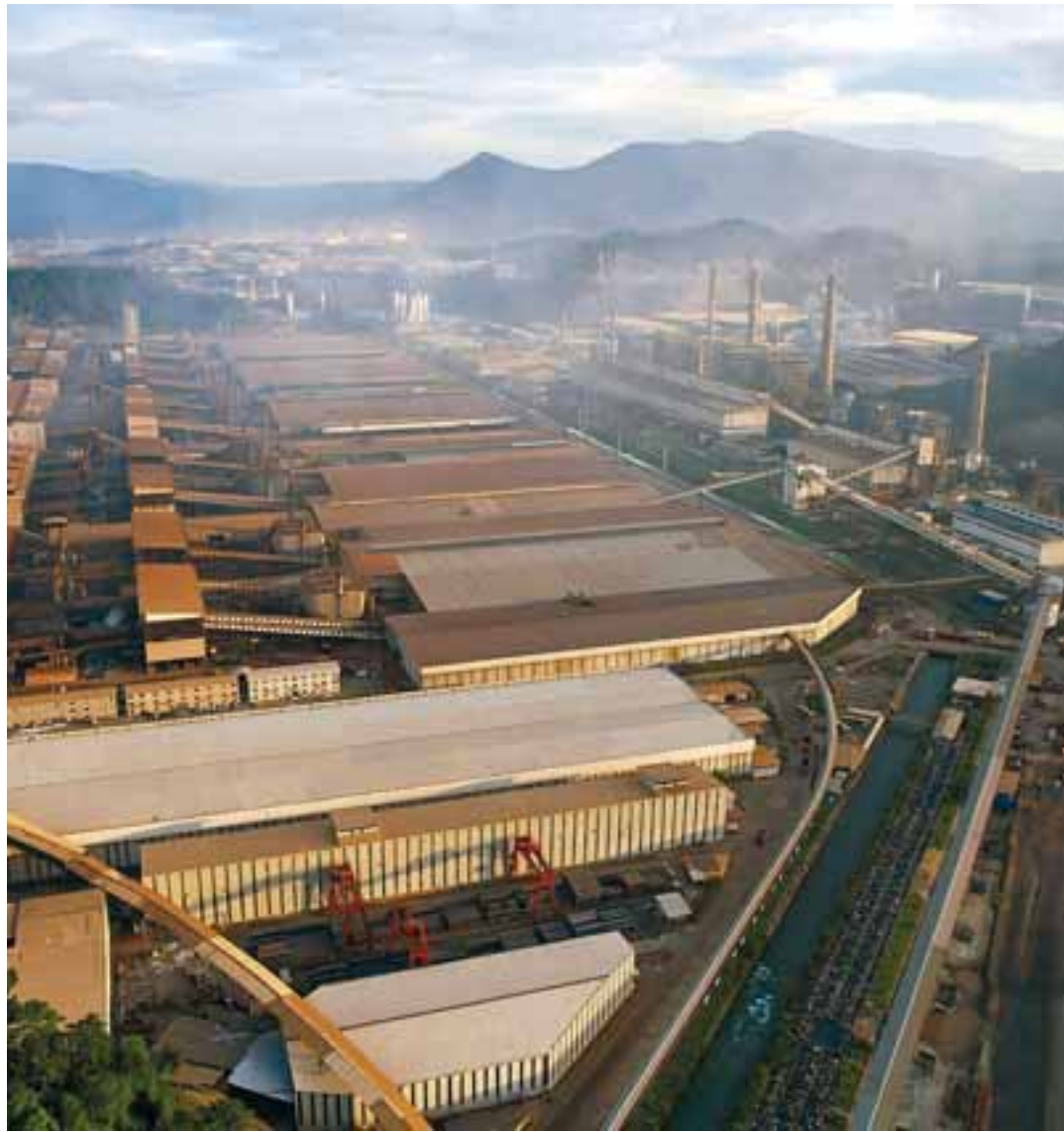
Το Indonesia Morowali Industrial Park (φωτογραφία), που ανήκει στην κινεζική Tsingshan, εκτείνεται σε 40 τετραγωνικά χιλιόμετρα και διαθέτει δεκάδες μεταλλουργεία νικελίου και χαλυβουργεία.
