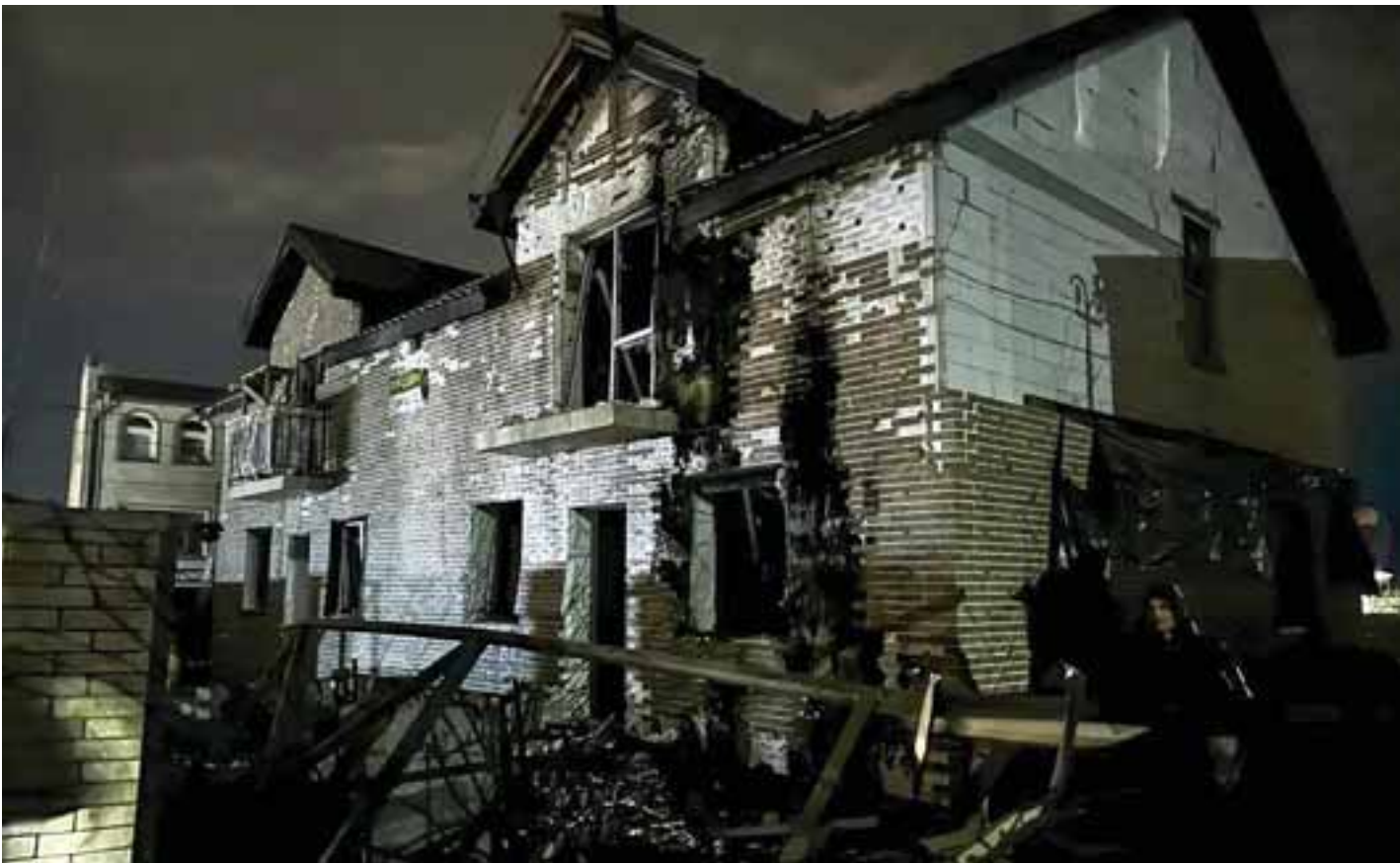
Κατεστραμμένο κτίριο μετά από επίθεση με drone στην περιοχή του Κιέβου. Σύμφωνα με την Κρατική Υπηρεσία Έκτακτης Ανάγκης, τουλάχιστον ένα άτομο έχασε τη ζωή του και άλλα τέσσερα τραυματίστηκαν ως αποτέλεσμα επιθέσεων ρωσικών μη επανδρωμένων αεροσκαφών τη νύχτα της 3ης Ιανουαρίου 2025.
