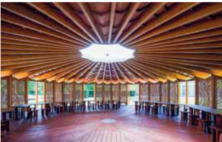
Μια περιμετρική κιονοστοιχία ερυθρελάτης διατάσσεται κάτω από έναν χαμηλό πτυχωτό θόλο που μιμείται τη δομή φύλλου φοίνικα.
