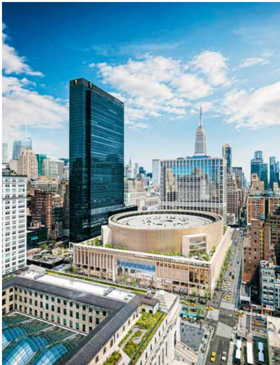
Η νέα μορφή του σιδηροδρομικού σταθμού Πεν Στέισον στο Μανχάταν.
