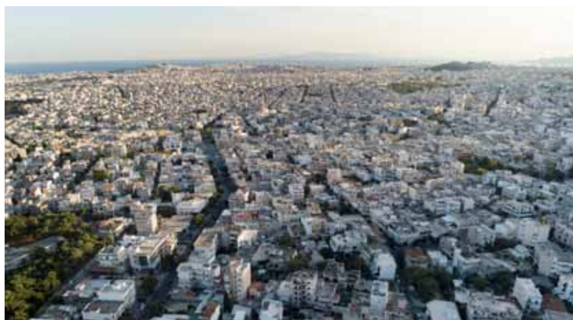
Η αυστηρή συσχέτιση του ύψους του «κουρέματος» με την εμπορική αξία της ακίνητης περιουσίας στον εξωδικαστικό αποθαρρύνει τους οφειλτές να προχωρήσουν σε ρύθμιση.
