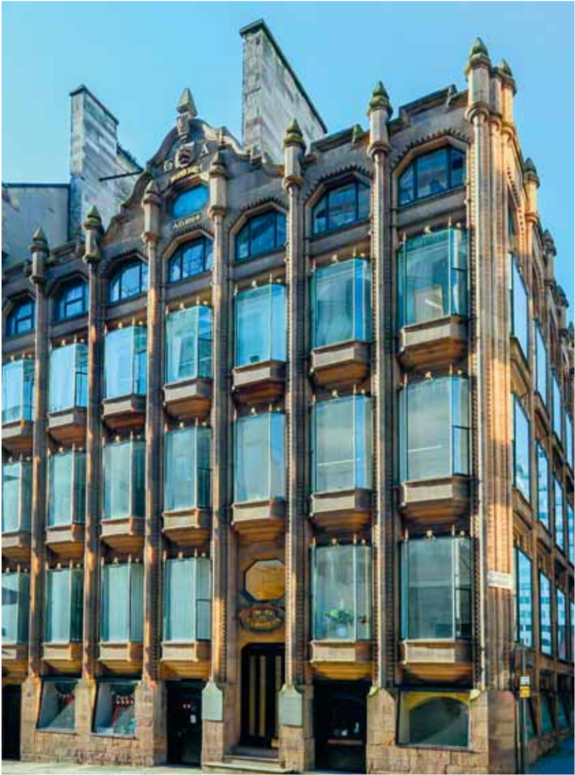
Oriel Chambers, το βικτωριανό κτίριο στο Λίβερπουλ που εισήγαγε τα υαλοπετάσματα το 1864.
