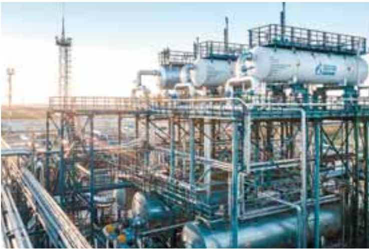
Δεύτερες σκέψεις για το πλαφόν στο πετρέλαιο φαίνεται να κάνει η Ουάσινγκτον, υπό τον αυξανόμενο κίνδυνο της αστάθειας στην αγορά του αργού, εν μέσω αυξήσεων στα επιτόκια.
