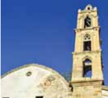
Στο εξωτερικό μέρος του ηλιακού του Αγίου Γεωργίου στο Πραστεϊό διακρίνεται η επιγραφή όπου σημειώνονται οι λεπτομέρειες της κατασκευής της: «Γέγονεν ο νάρθηξ ούτος | εν έτει σωτηρίω ακβ (1922).
