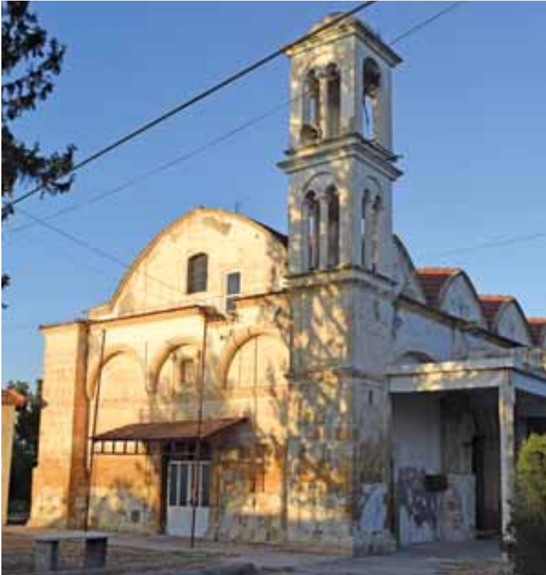
Η εκκλησία της Αγίας Παρασκευής στην Αγγαστίνα. Το καμπαναριό της στέκει ακόμα, έργο και αυτό του Γεωργίου Ασσιώτη από το Καϊμακλί.
