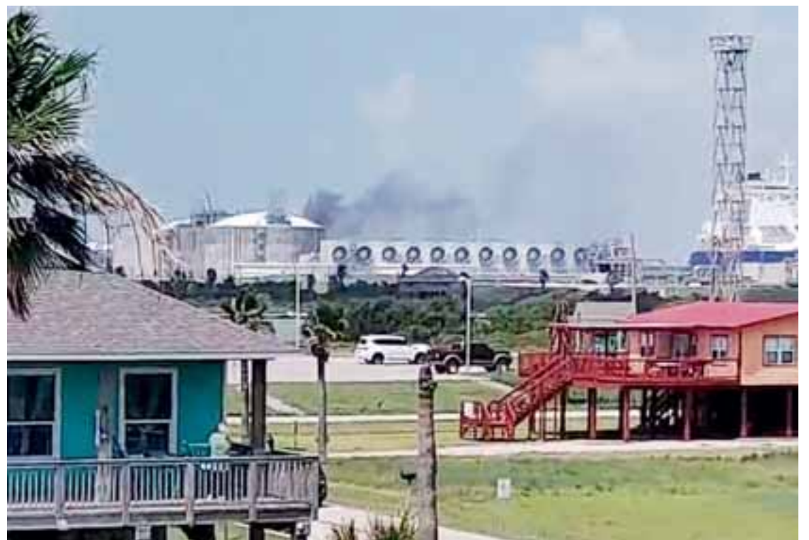
Η έκρηξη που σημειώθηκε τον Ιούνιο στις εγκαταστάσεις της εταιρείας Freeport LNG στο Τέξας, στον κόλπο του Μεξικού, θα έχει ως αποτέλεσμα να μειωθούν βραχυπρόθεσμα οι εξαγωγές αμερικανικού LNG.
