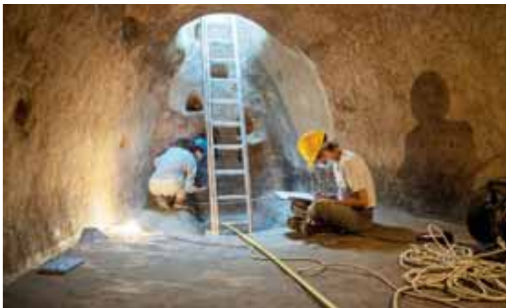
Στην υλοποίηση ενός έργου αποκατάστασης στον υπόσκαφο οικισμό της Αγριλιάς, με βάση παραδοσιακές τεχνικές, συμμετείχαν και τοπικοί τεχνίτες.
