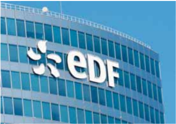
Σε ανακοίνωση του γαλλικού κολοσσού ενέργειας, EdF, τονίζεται ότι εντοπίστηκαν ενδείξεις διάβρωσης σε τρεις αντιδραστήρες από τους έξι που έχει αποφασίσει να ελέγξει από τον Φεβρουάριο. Παράλληλα υπήρξαν αντίστοιχες ενδείξεις σε ακόμη έναν από τους αντιδραστήρες στους οποίους είναι σε εξέλιξη τα έργα συντήρησης.
