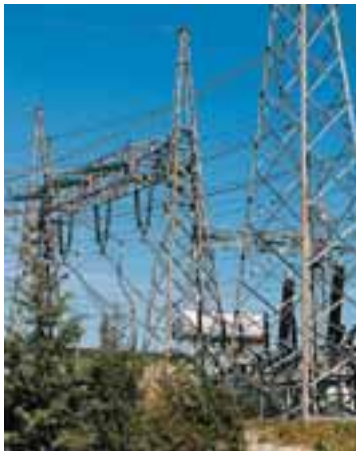
Στην Ελλάδα, η μέση χονδρεμπορική τιμή ρεύματος για τον Νοέμβριο διαμορφώνεται στα 228,36 ευρώ/MWh, πολύ πιο πάνω από τα υψηλά επίπεδα των 198,32 ευρώ/MWh του Οκτωβρίου.
