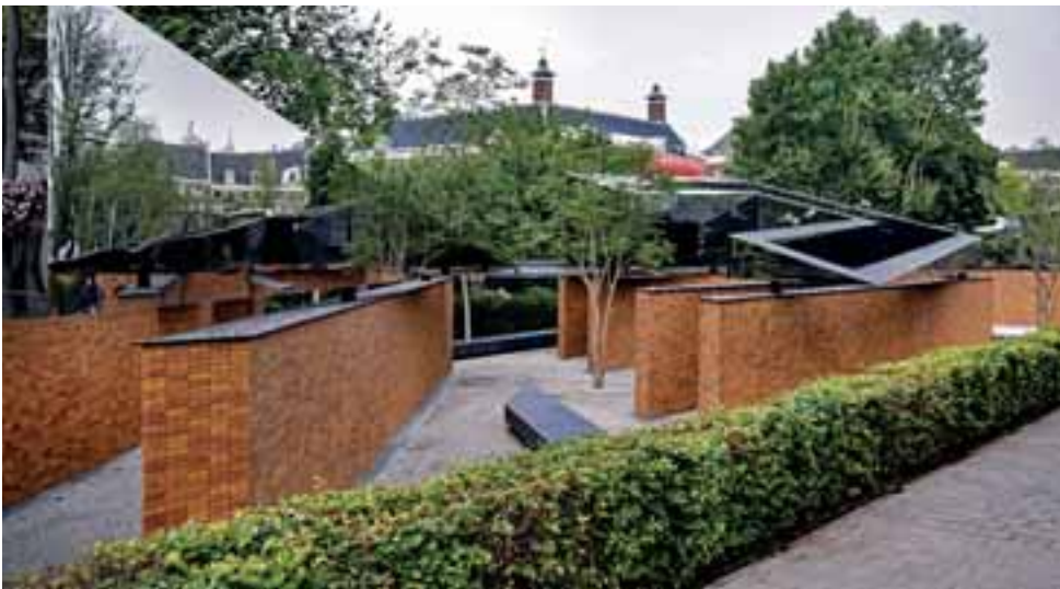
Άποψη από το Εθνικό Μνημείο Ονομάτων για το Ολοκαύτωμα, στο Άμστερνταμ, έργο του αρχιτέκτονα Daniel Libeskind. Για τα εγκαίνια του θα τεθεί σε ισχύ επείγον δημοτικό διάταγμα.
