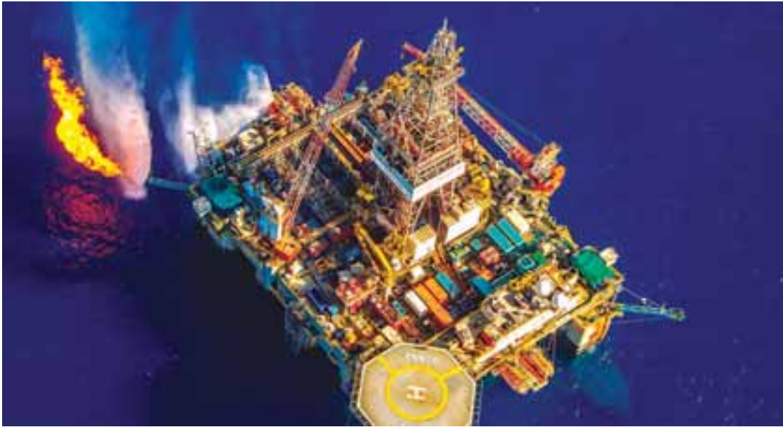
Το άναμμα της φλόγας στο τεμάχιο 10 με βάση τους σχεδιασμούς της ΕκxonMobil θα πραγματοποιηθεί τον ερχόμενο Ιανουάριο-Φεβρουάριο και θα αποσκοπεί στην πρώτη δοκιμή ανόρυξης του φυσικού αερίου.
