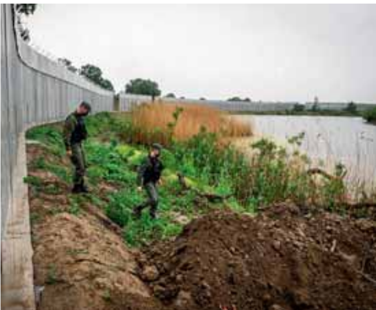
Ο μήκους 27 χλμ. φράχτης στον Εβρο είναι έτοιμος και εξοπλισμένος με κάμερες και ραντάρ που σαρώνουν την τουρκική πλευρά.
