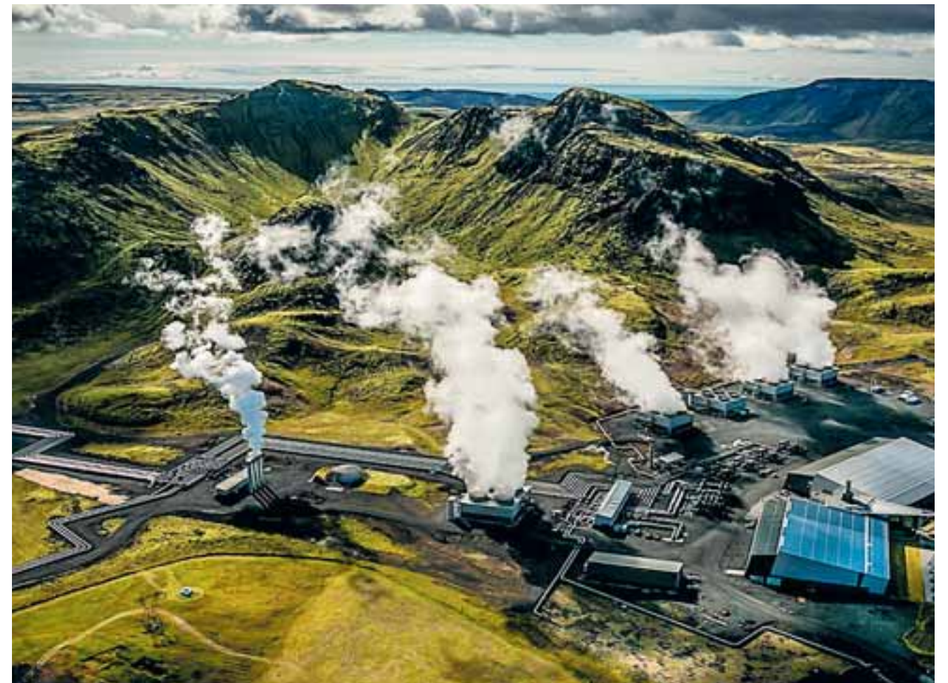
Η εταιρεία εφαρμόζει το συγκεκριμένο εγχείρημα στο ισλανδικό εργοστάσιο Χελισέντι, μία από τις μεγαλύτερες γεωθερμικές μονάδες ηλεκτροπαραγωγής στον κόσμο.
