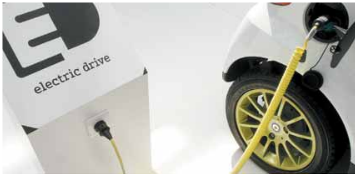
Πεδίο δόξης λαμπρό αποτελεί η ηλεκτροκίνηση για τα σούπερ μάρκετ. Φορτιστές για ηλεκτρικά αυτοκίνητα έχουν ήδη εγκαταστήσει η «Δ. Θανάπουλος» και η My Market, ενώ η «ΑΒ Βασιλόπουλος» έχει υπογράψει σχετικό μνημόνιο συνεργασίας με τη ΔΕΗ.
