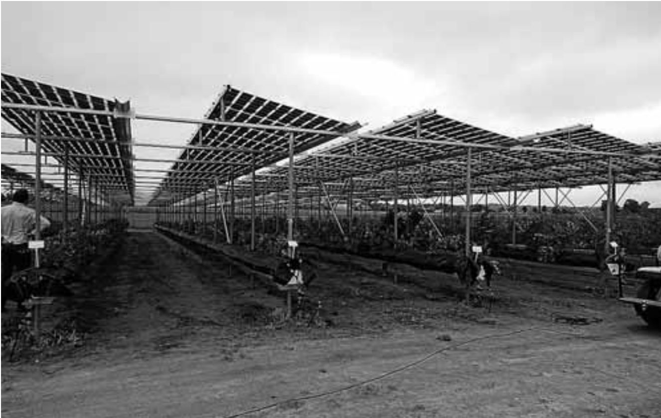
Το πρωτοποριακό στέγαστρο, τοποθετημένο σε καλλιέργεια με μύρtila στην Ολλανδία. Το διαφανές ηλιακό πάνελ φέρει ειδική επίστρωση από νανοϋλικά.
