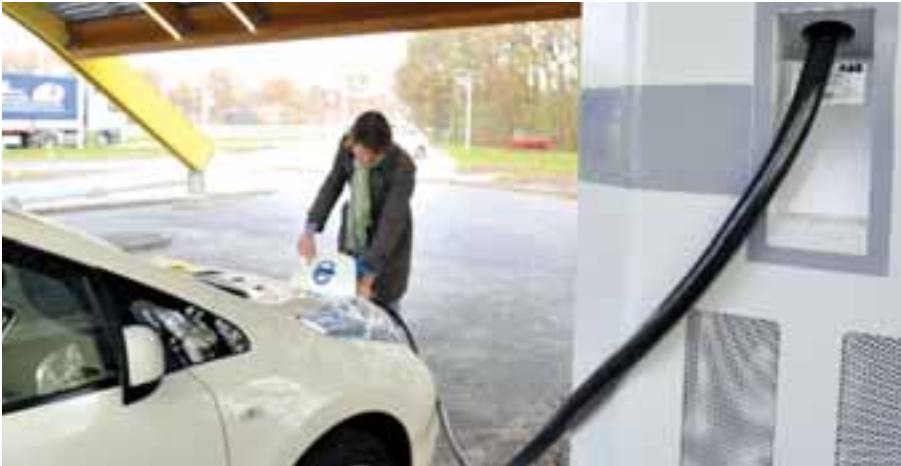
Αυτή την περίοδο, εκατοντάδες σταθμοί φόρτισης κατασκευάζονται στα κέντρα των πόλεων και στους αυτοκινητοδρόμους.
