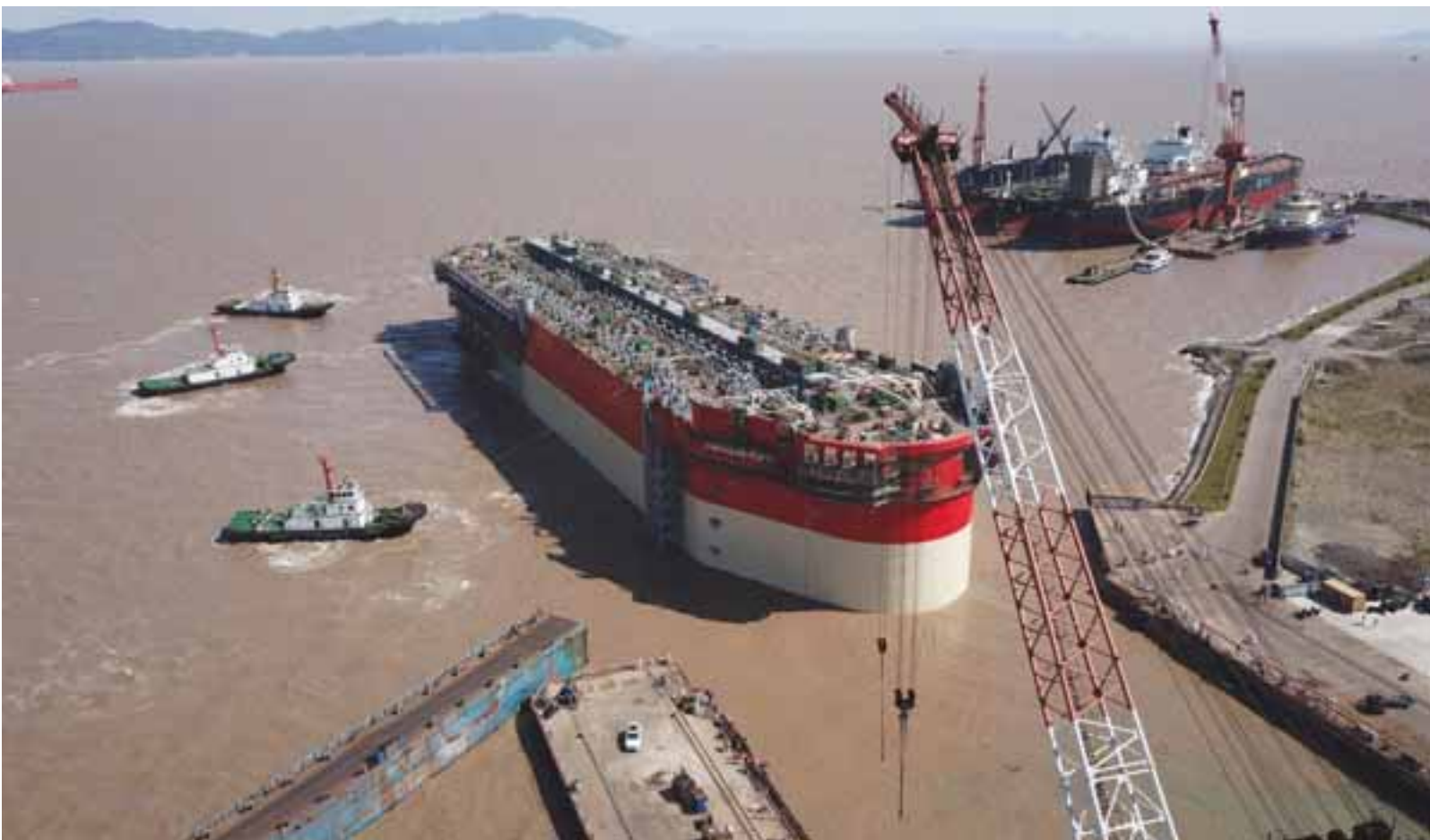
Η πλωτή μονάδα παραγωγής, αποθήκευσης και εκφόρτωσης στην Ανατολική Μεσόγειο Energean Power FPSO βρίσκεται στο στάδιο της κατασκευής στα ναυπηγεία της COSCO στο Ζουσάν της Κίνας. Εντός της ισραηλινής ΑΟΖ αναμένεται να βρίσκεται τον Μάρτιο του 2021.
