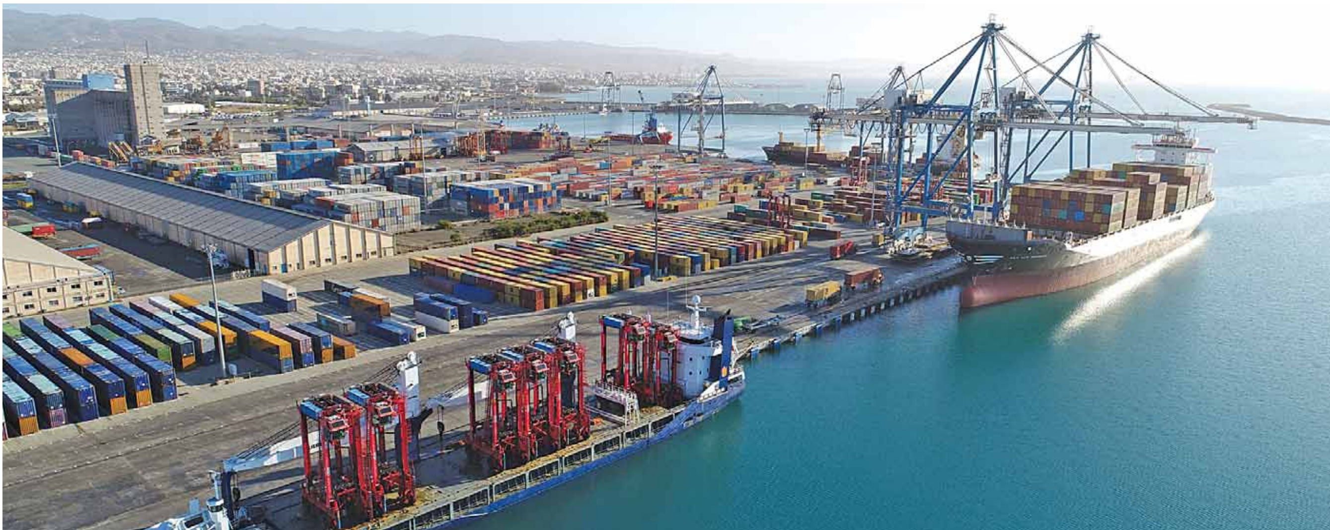
Οι δύο νέες γερανογέφυρες μπορούν να διαχειριστούν κατά μέσο όρο 35 εμπορευματοκιβώτια την ώρα, σε σχέση με 22,5 εμπορευματοκιβώτια που είναι ο μέσος όρος των παλιών γερανογεφυρών.
