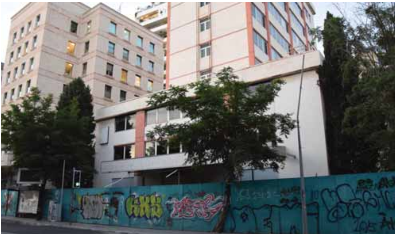
Σημαντική αναβάθμιση στην Λεωφόρο Μακαρίου από την επένδυση της Ισραηλινής εταιρείας Fattal Hotel Management. Πρόκειται για μπουτίκ ξενοδοχείο 14 ορόφων και 198 δωμάτων.
