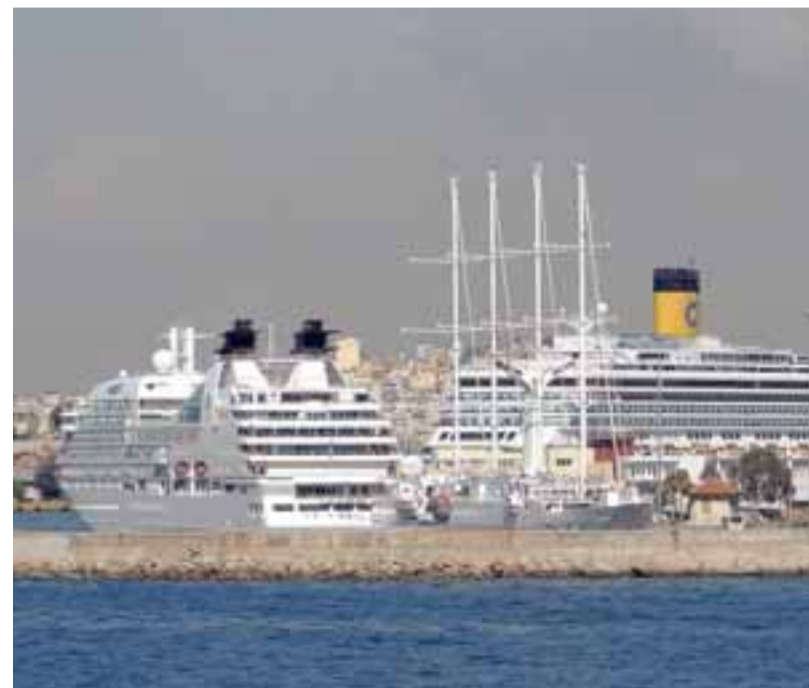
Με την ολοκλήρωση του έργου, το λιμάνι του Πειραιά θα μπορεί πλέον να δέχεται τα μεγαλύτερα κρουαζιερόπλοια του κόσμου. Ειδικότερα, βάσει των σχετικών προδιαγραφών, στον Πειραιά θα μπορούν να εξυπηρετούνται έως τέσσερα κρουαζιερόπλοια νέας γενιάς, μήκους άνω των 400 μέτρων έκαστο.
