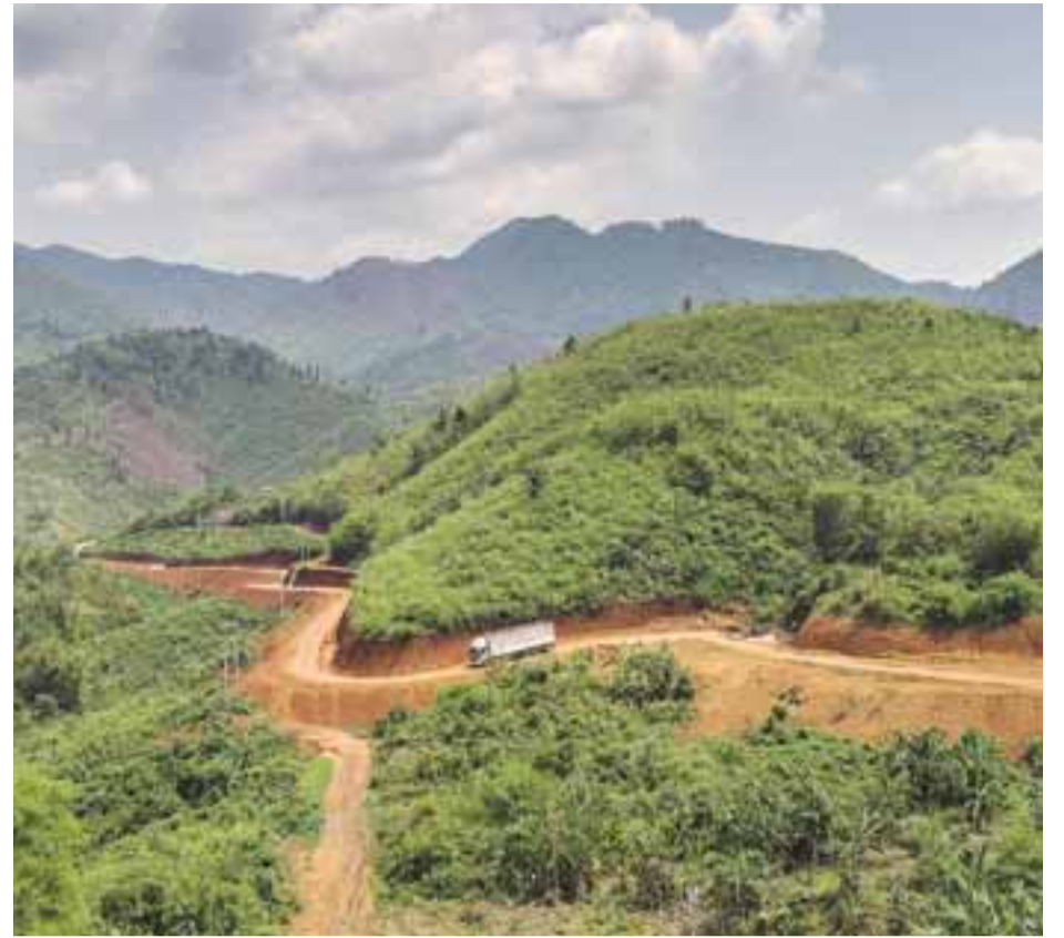
Νέος δρόμος διανοίγεται σε δύσβατη περιοχή του Λάος, μέρος της επενδυτικής πρωτοβουλίας του Πεκίνου.
