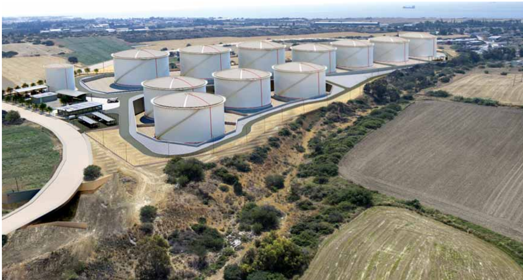
Οι έντεκα δεξαμενές αποθήκευσης υγρών καυσίμων του Κυπριακού Οργανισμού Διαχείρισης Αποθεμάτων Πετρελαιοειδών (ΚΟΔΑΠ) θα ανεγερθούν σε περιοχή κοντά στο Τσιμεντοποιείο και αναμένεται να ολοκληρωθεί το 2020. Η πρώτη φάση του έργου περιλαμβάνει έξι δεξαμενές και η δεύτερη άλλες πέντε.
