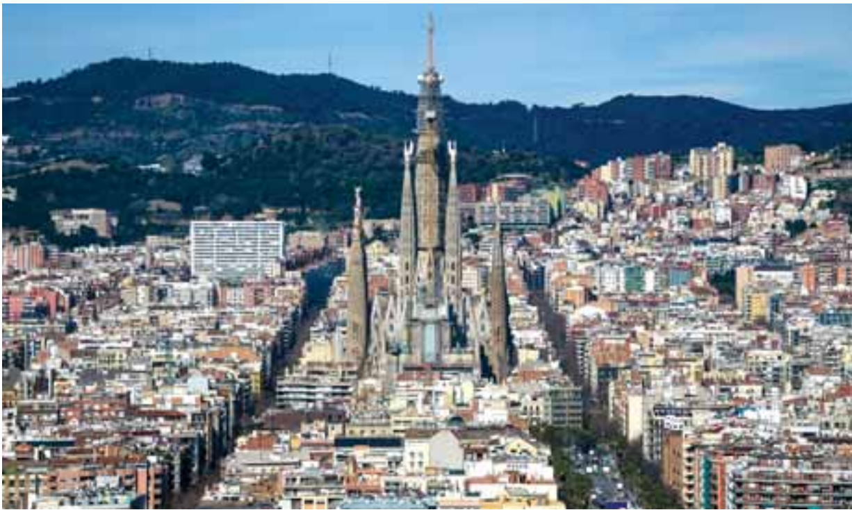
Η εκκλησία Sagrada Família στη Βαρκελώνη της Ισπανίας έφτασε στο μέγιστο ύψος της των 172,5 μέτρων, με την εγκατάσταση του άνω βραχίονα του Σταυρού του Πύργου του Ιησού.
