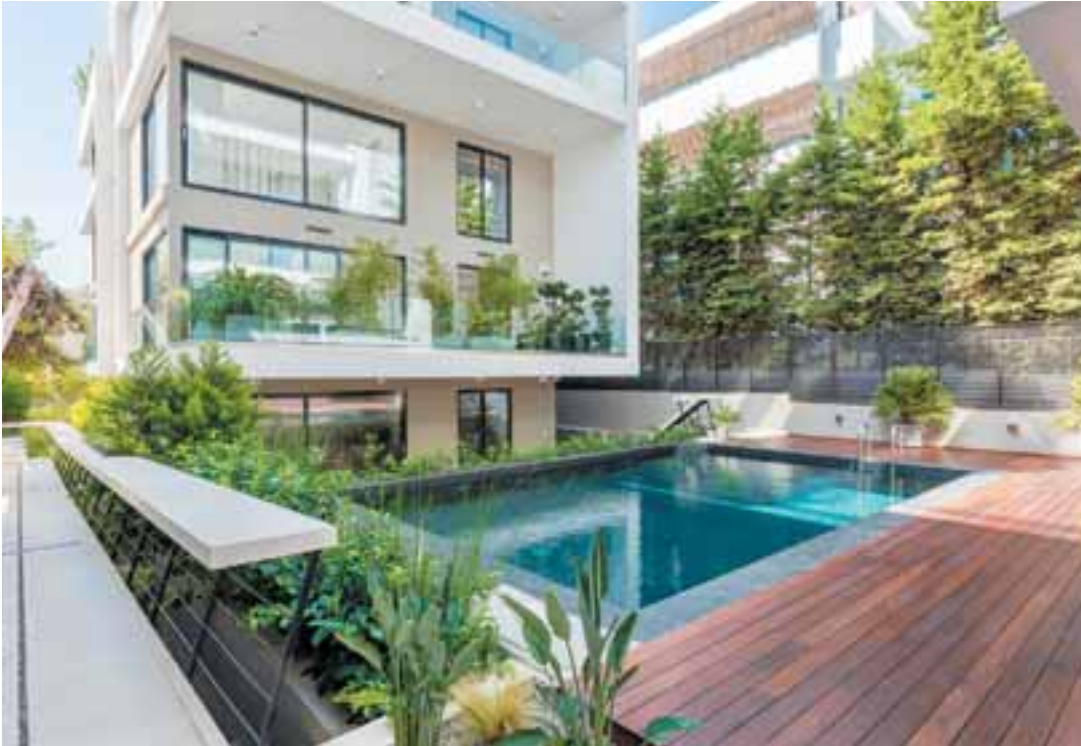
Στην ανάπτυξη δύο διδυμών συγκροτημάτων κατοικιών στο κέντρο της Βούλας προχώρησε ένας Αιγύπτιος κατασκευαστής. Πρόκειται για 15 διαμερίσματα με κοινόχρηστη πισίνα, τα οποία θα πωληθούν σε Αιγύπτιους πελάτες του συγκεκριμένου επιχειρηματία, ο οποίος έχει αναπτύξει κι άλλα αντίστοιχα ακίνητα.
